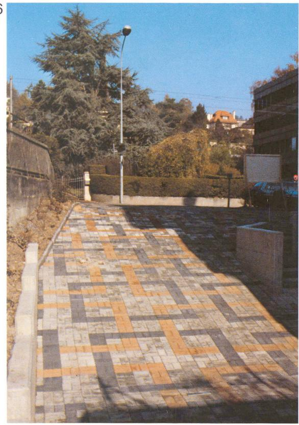
Les pavés en béton peuvent être fabriqués mécaniquement. Ils ont un grand nombre de formes diverses et depuis peu sont livrables également en différentes teintes. Ainsi, les pavages autrefois uniformément gris peuvent être colorés eux aussi. A l'intérieur des bâtiments, on a l'habitude de pouvoir marcher sur des revêtements divers et sur de beaux tapis, pourquoi ne pourrait-il pas en être de même à l'extérieur, spécialement dans les zones piétonnières?
