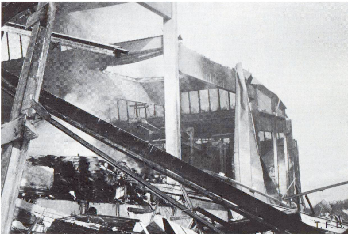
Fig. 5 Le comportement différent des constructions en métal ou en béton est bien visible sur cette photo.
