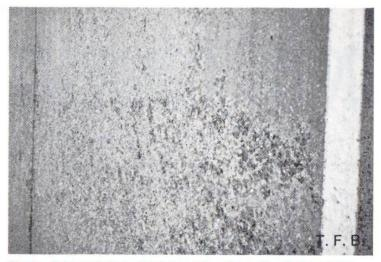
Fig. 1 Dégats de gel en présence de sel sur une route en béton.
