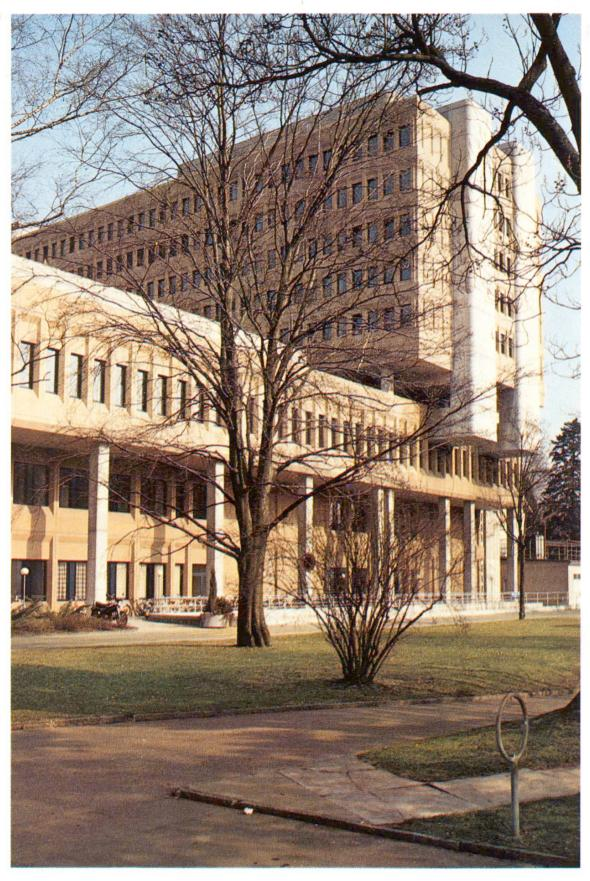
Fig. 9 Hôpital cantonal, Aarau Architecte: Hajnos, Zurich Eléments de béton colorés puis traités au jet de sable.
