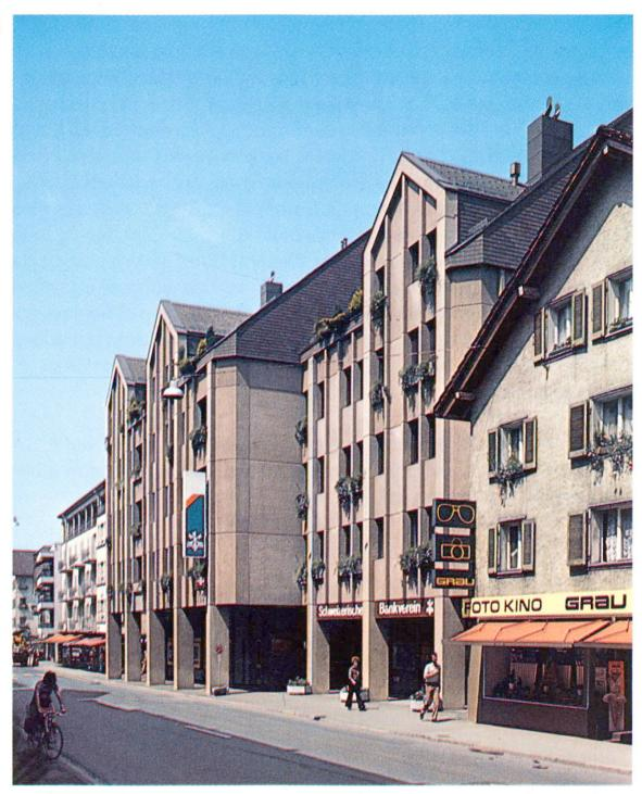
Fig. 10 Union de Banques Suisses, Baar Architecte: Weber Bau AG, Baar. Collaborateur: H. Hofstetter Eléments de béton colorés puis bouchardés.
