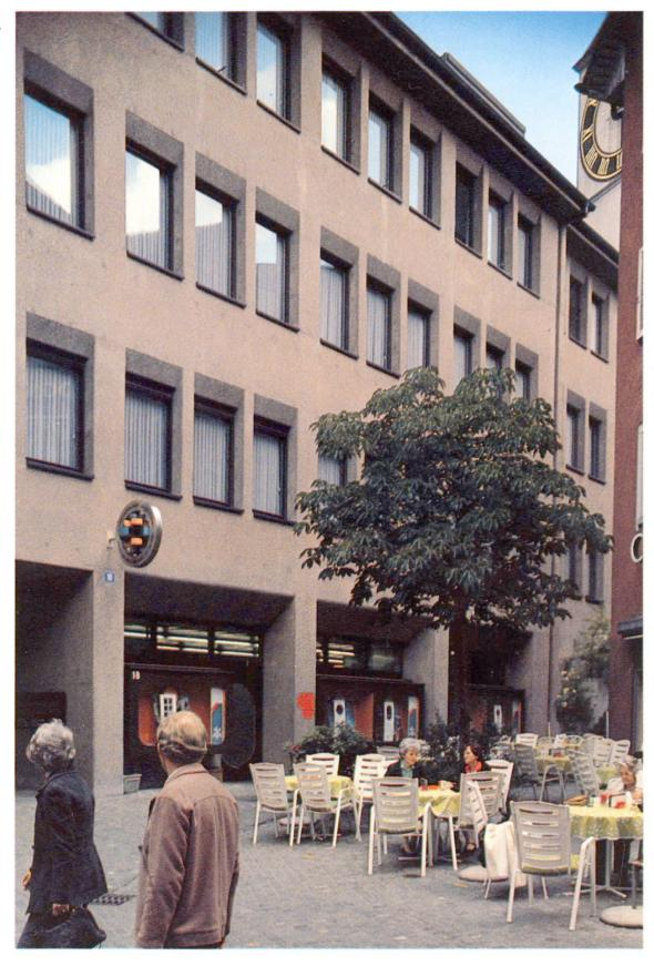
Fig. 4 Bâtiment des cantines de l'Union de Banques Suisses, Zurich Architecte: Georg Künzler, Dietikon Béton coloré puis bouchardé.
