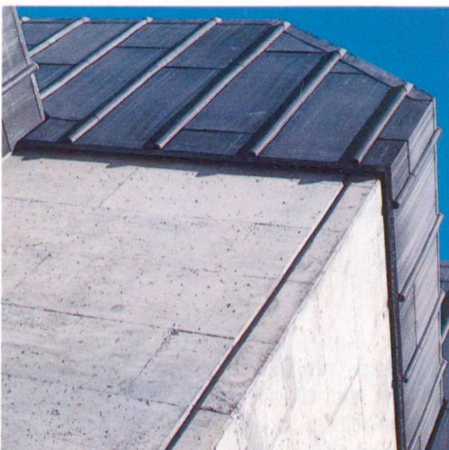
En ce qui concerne sa construction, le bâtiment se compose de trois parties principales: Les bases massives en béton armé brut qui forment une sorte de socle; une charpente en acier qui repose en partie sur le socle massif, en partie sur des piliers en acier; les différentes couches de l'enveloppe extérieure en construction légère avec un revêtement en plaques de plomb striées.
