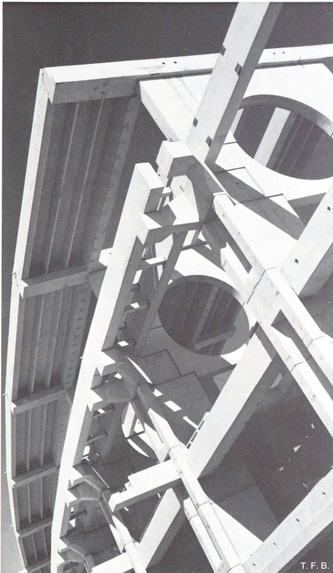
Fig. 4 Cadres porteurs de la partie médiane avec les plaques de raidissement à évidements circulaires. Les poutres supportant la toiture de la partie latérale reposent sur des consoles en forme de fourche, ce qui confère à cet ensemble un bon aspect architectural.
