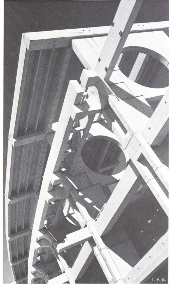
Fig. 4 Cadres porteurs de la partie médiane avec les plaques de raidissement à évidements circulaires. Les poutres supportant la toiture de la partie latérale reposent sur des consoles en forme de fourche, ce qui confère à cet ensemble un bon aspect architectonique.
