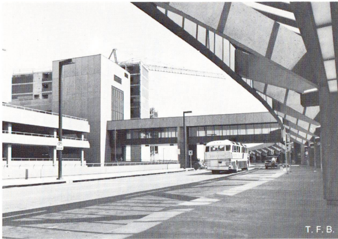
Fig. 7 La route d'accès surélevée vue d'une des entrées de l'aérogare. A gauche, le bâtiment de parking ainsi que les passerelles.
