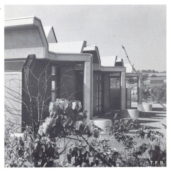
cohérent. D'après leurs fonctions, il s'est établi entre ces différentes parties une certaine hiérarchie qui est mise en évidence par la conformation de chacune d'elles. Vu de l'extérieur, c'est le squelette de poutres apparentes en béton qui est l'élément dominant. Il est garni par des parois pleines en planches de bois posées obliquement. Les fenêtres placées tout en haut sont inaccessibles et on ne peut voir à l'intérieur qu'aux emplacements des entrées.
