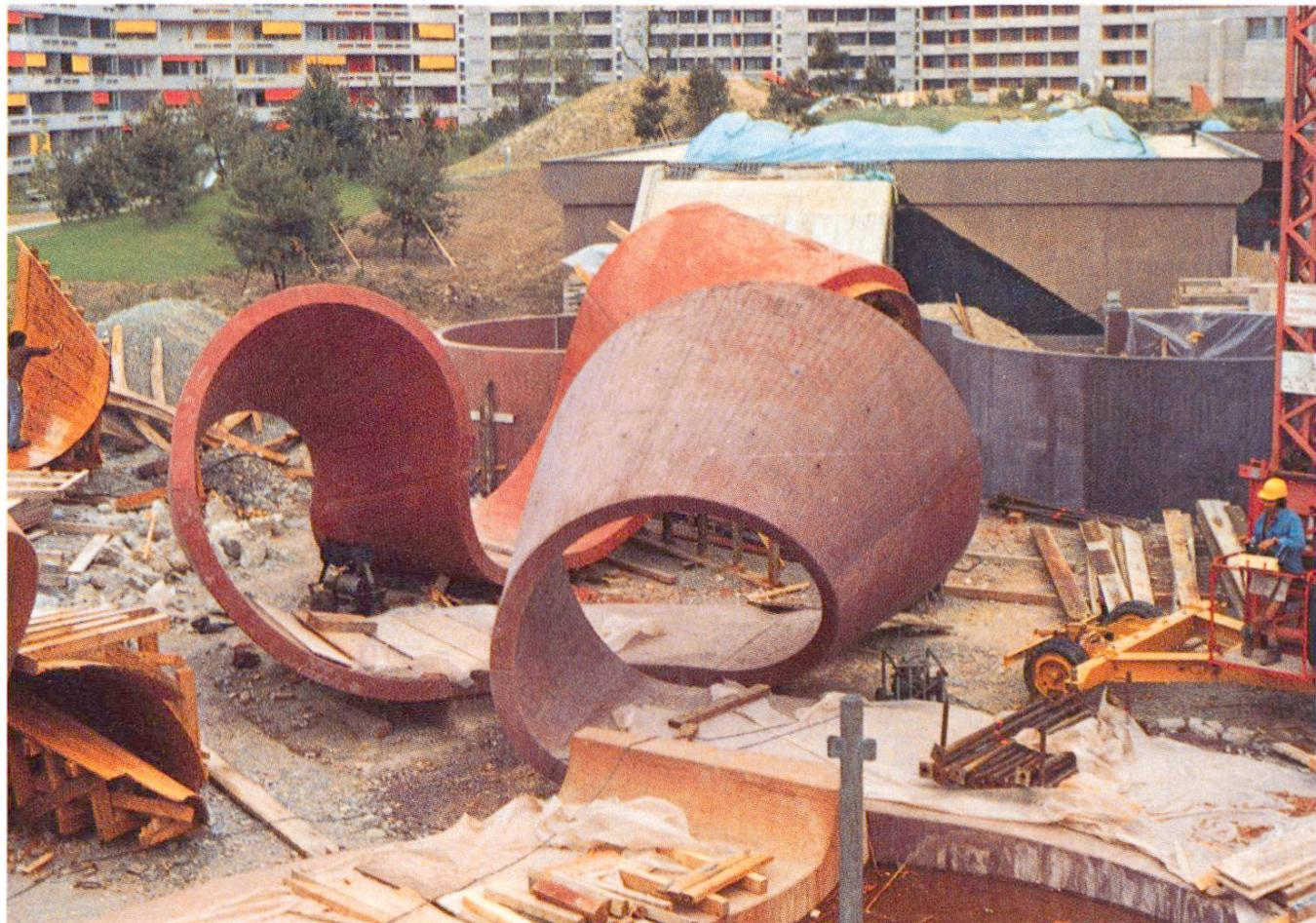
les menuisiers qui ont monté le coffrage et par les maçons qui ont mis en place le béton. C'est l'artiste auteur du projet qui, après divers essais, a fixé lui-même la composition du béton en ce qui concerne le dosage et ciment et en colorant. Le béton a été préparé sur place dans un petit malaxeur. Il s'agissait de le mélanger très soigneusement de telle façon qu'il ait une consistance onctueuse et qu'il soit très homogène.
