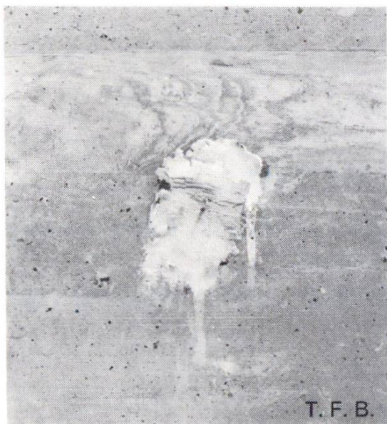
Fig. 5 La pâte absorbante a séché. Elle est devenue noire aux endroits où elle a absorbé du bitume.
