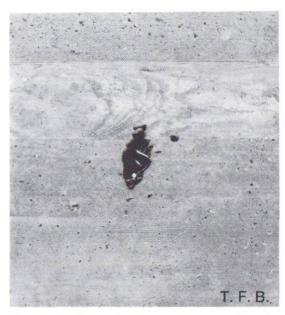
Fig. 1 Surface de béton avec tache de bitume.
