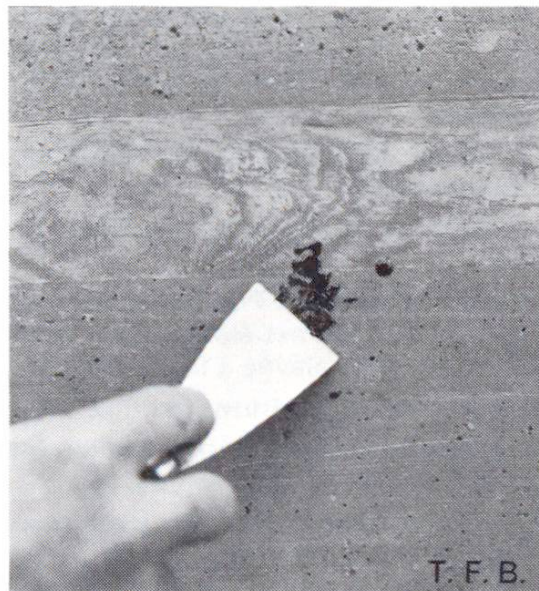
Fig.2 On enlève à la spatule autant de bitume que possible.
