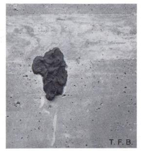
Fig. 8 Nouvelle application de la pâte absorbante.
