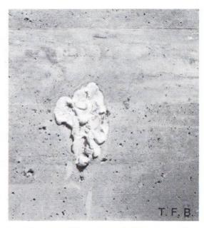
Fig. 10 L'a pâte est complètement desséchée.
