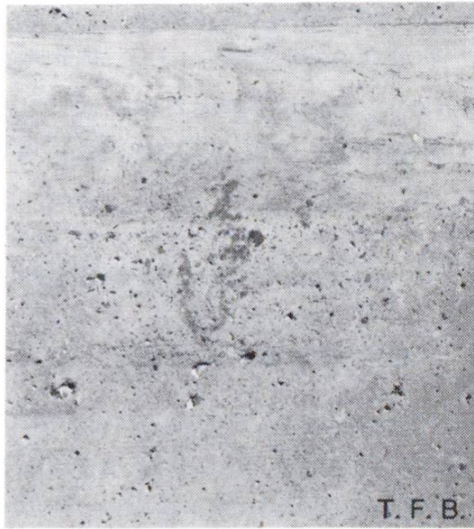
Fig. 12 La tache a disparu, il n'en reste que quelques traces.
