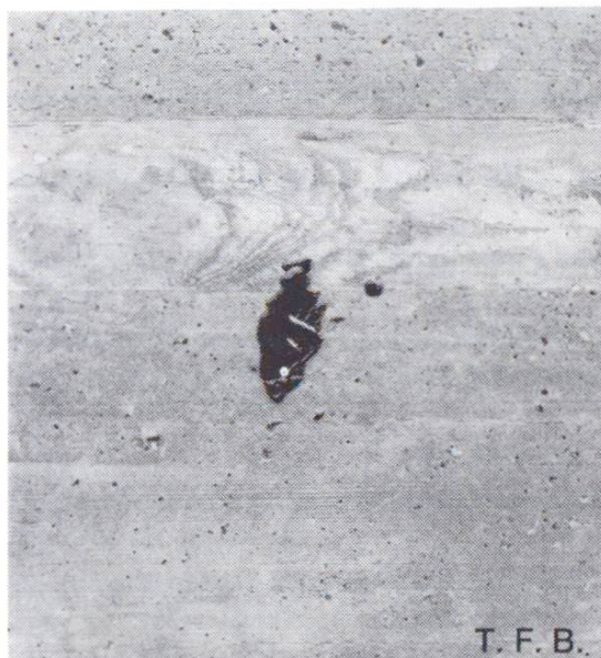
Fig.1 Surface de béton avec tache de bitume.
