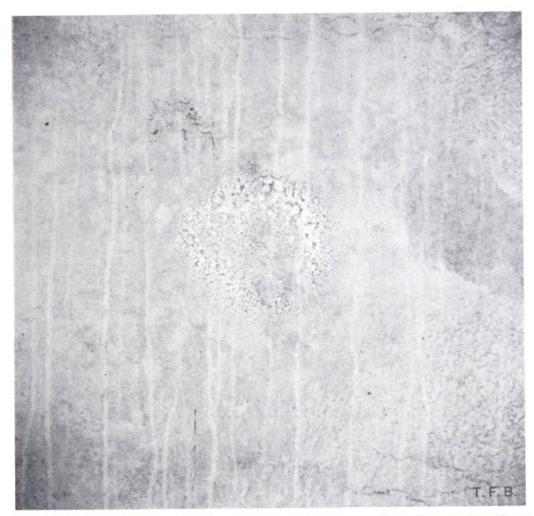
Fig. 3 Une huile de coffrage liquide, prisonnière entre le béton et le coffrage horizontal, est dispersée par la vibration en petites gouttes qui laissent des marques à la surface du béton
