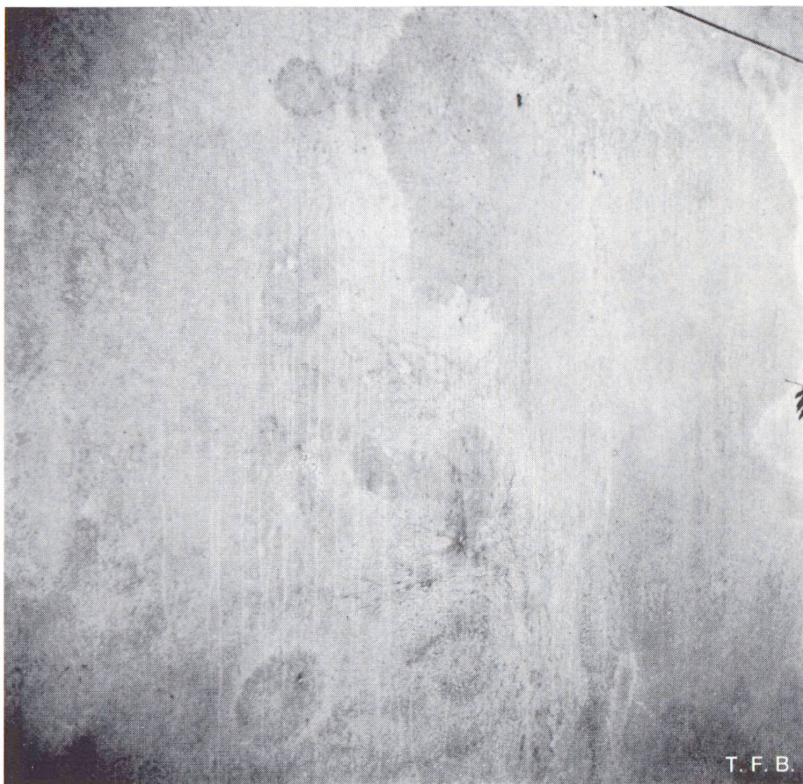
Fig. 2 Laminé lors de la mise en place du béton, ce produit de décoffrage pâteux de type C laisse des marques à la surface du béton.
