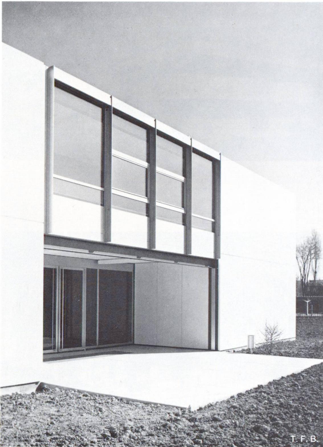
Fig. 5 Ecole à Hubersdorf. Béton à coffrage lisse et peint.
