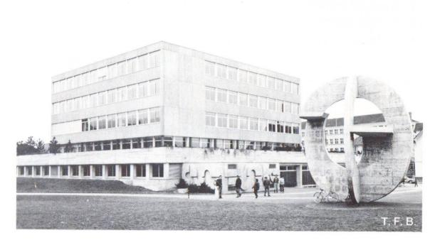
Fig. 1 Ecole professionnelle à Limmattal avec béton apparent classique et plaques de façade à texture striée.
