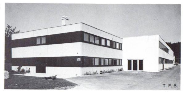
Fig. 6 Bâtiment pour bureaux au Mont. Béton lavé avec granulat de teinte claire.
