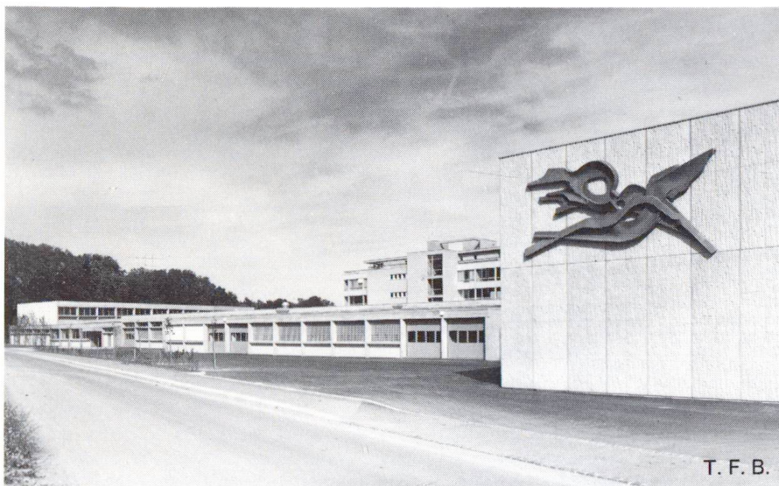
Fig. 3 Ecole professionnelle de Colombier. Dalles de façade avec structure «Prewi».
