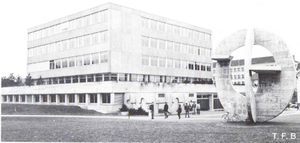
Fig. 1 Ecole professionnelle à Limmattal avec béton apparent classique et plaques de façade à texture striée.
