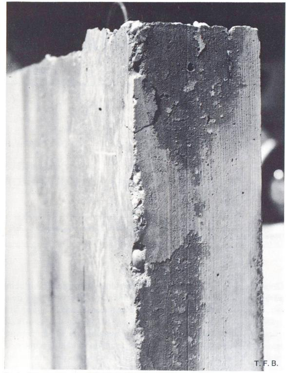
Fig. 1 Arête rompue sous l'effet de la dilatation du coffrage en bois.
