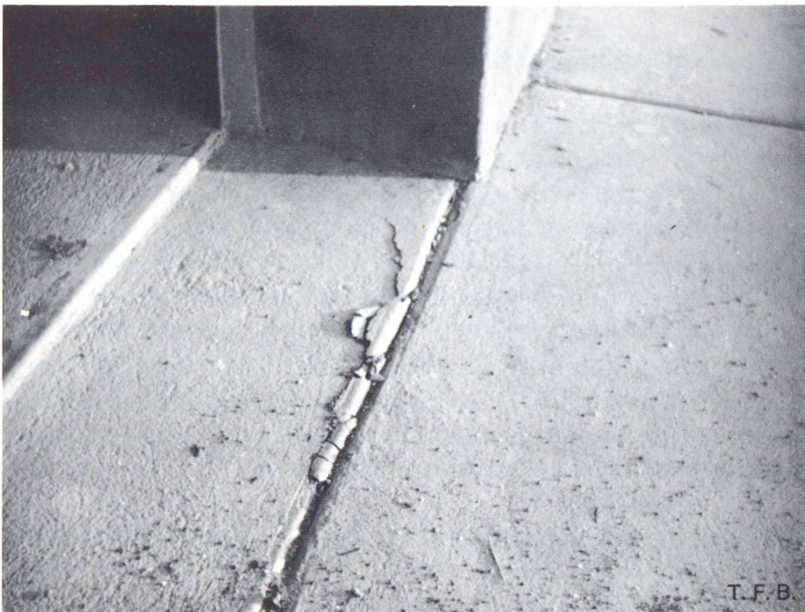
Fig. 4 Béton d'une arête, amaigri et détérioré par le gel en raison d'un excès de zèle et probablement d'un apport d'eau supplémentaire lors du façonnage de l'arête.
