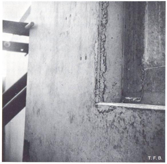
Fig. 2 Conséquence d'un manque d'étanchéité du coffrage de l'arête. Le béton a été amaigri à cause de la fuite du mortier.
