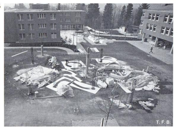
Fig. 1 Vue du chantier. Quelques fondations, des colonnes et des éléments du bassin sont déjà bétonnés. Au sol, on distingue des chablons qui permettent de fixer exactement la forme des éléments en plan.
