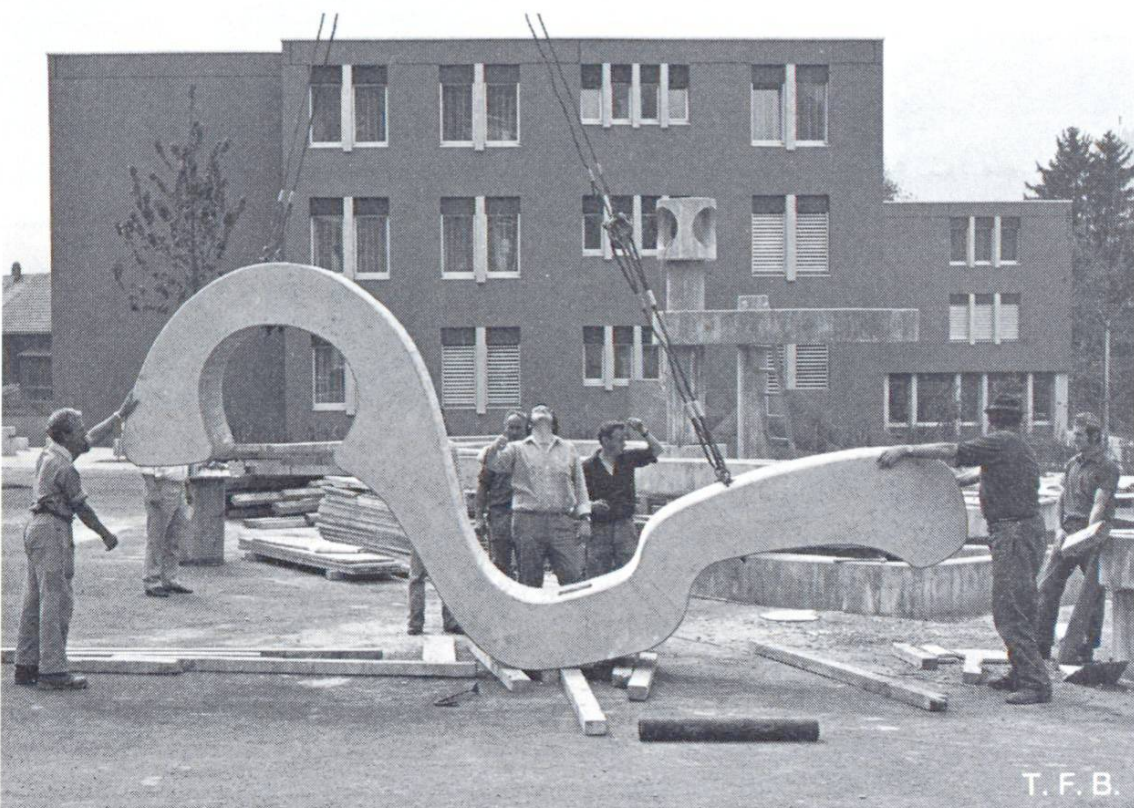
Fig. 5 L'élément ornemental soulevé pour être monté sur la colonne.
