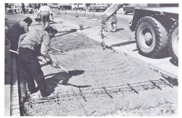
Fig. 3 Mise en œuvre de béton liquide sur un petit chantier. Revêtement pour une halte de bus.
