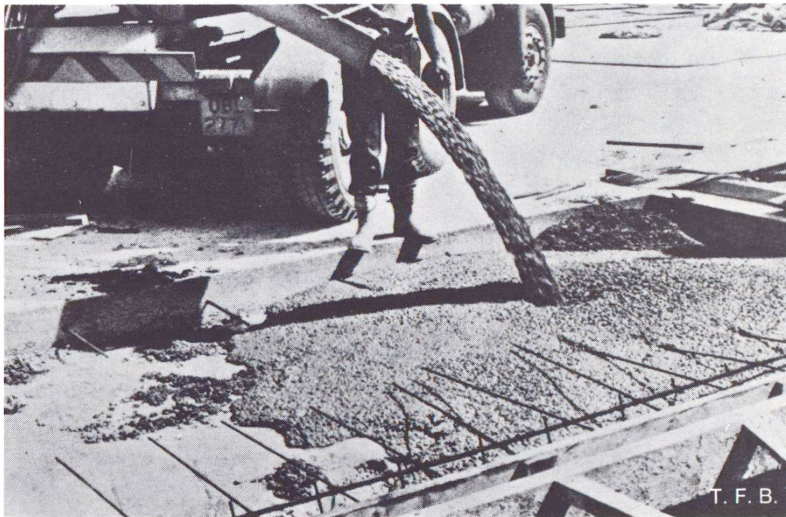
Fig. 2 Le béton liquide se met en place de lui-même sans ségrégation (photo tirée du rapport CCA, v. bibliographie).
