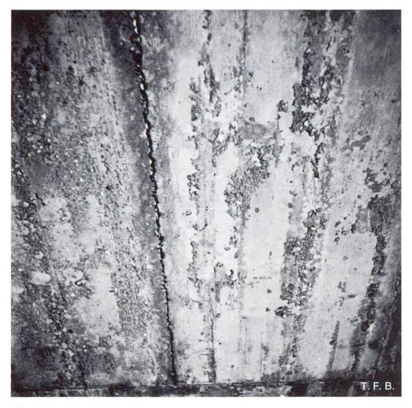
Fig. 5 Un béton à faible teneur en ciment est enclin au ressuage ce qui provoquera des déteriorations de la surface.
