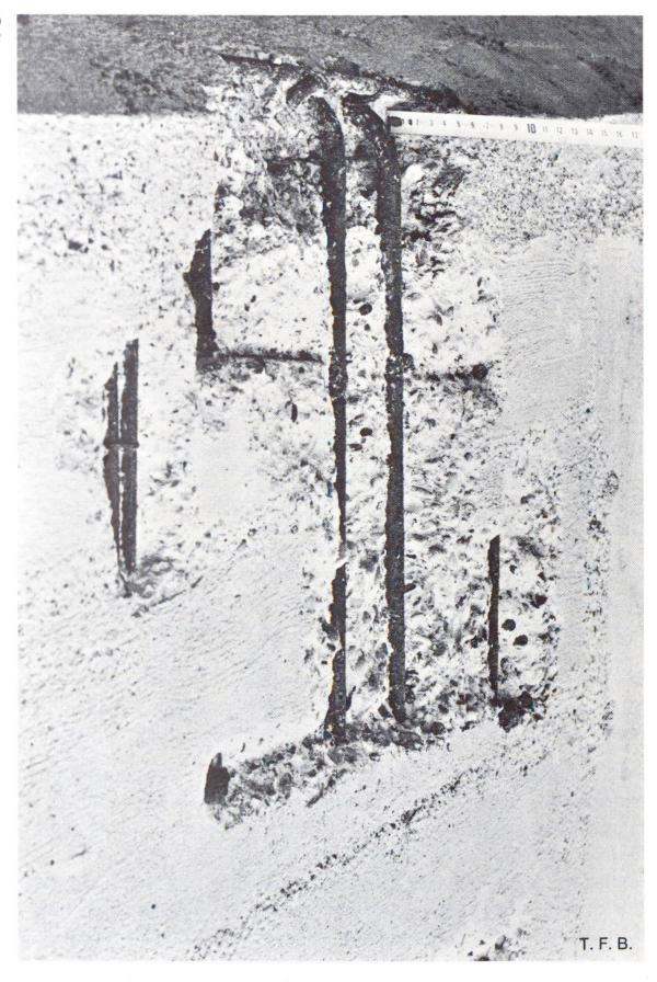
Fig. 1 Une teneur en ciment insuffisante et une trop faible couverture de l'armature augmentent le danger de corrosion de cette dernière. Non seulement le béton sous-dosé contient moins d'hydrate de chaux protecteur, mais celui-ci est détruit plus rapidmenent à cause de la grande porosité.
