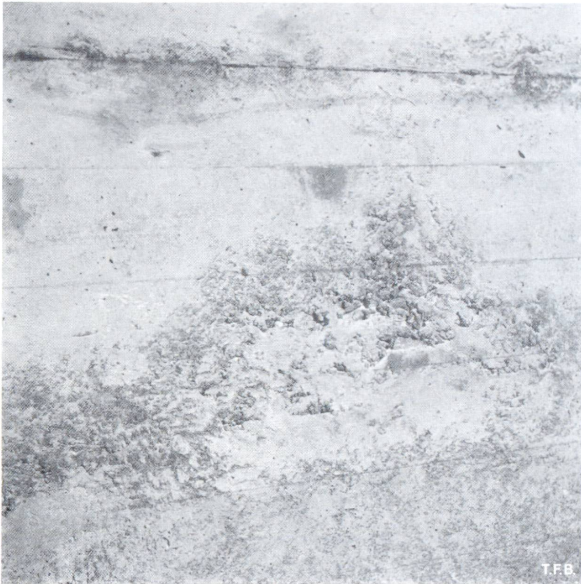
Fig. 4 Nid de gravier partiellement rempli de mortier lors de la vibration. Pendant cet écoulement, les granulats ont formé un filtre où les grains de ciment se sont concentrés de la même façon qu'au cours de l'écoulement par des fentes ou des trous du coffrage (fig. 2 et 3).
