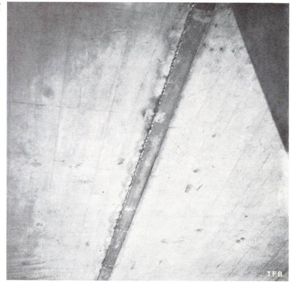
Fig. 1 Joint non étanche entre un panneau de coffrage et la planche de remplissage. Formation d'une grosse bavure.
