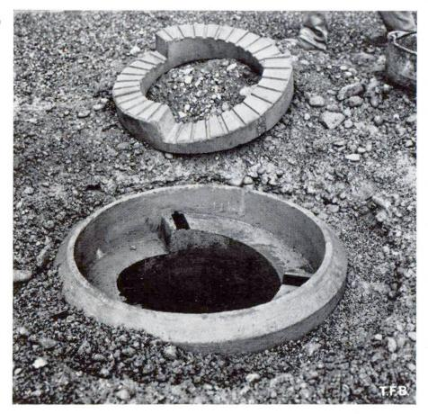
Fig. 6 Anneau inférieur en place lors de la mise en forme.
