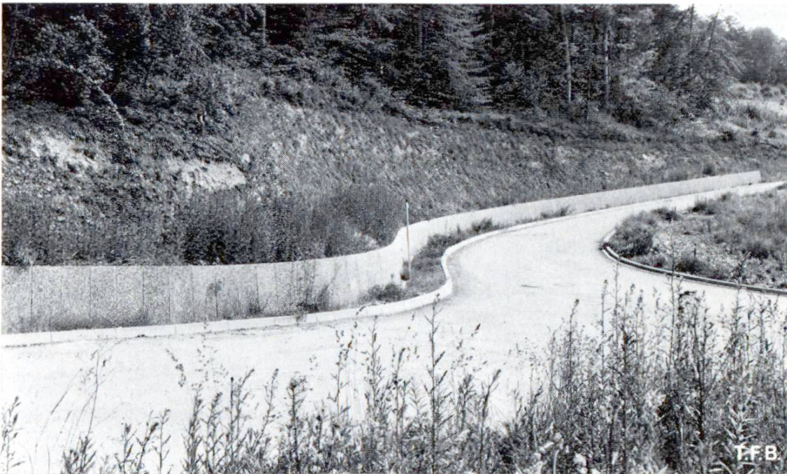
Fig. 4 Des éléments en L placés côte à côte forment un petit mur de pied de talus. Les surfaces apparentes sont en béton lavé.
