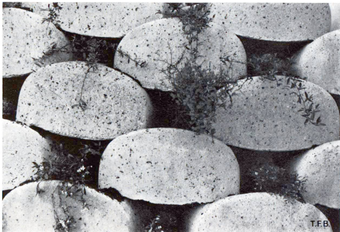
Fig. 10 Parement d'un mur formé de «pierres en cuillère», avec végétation.
