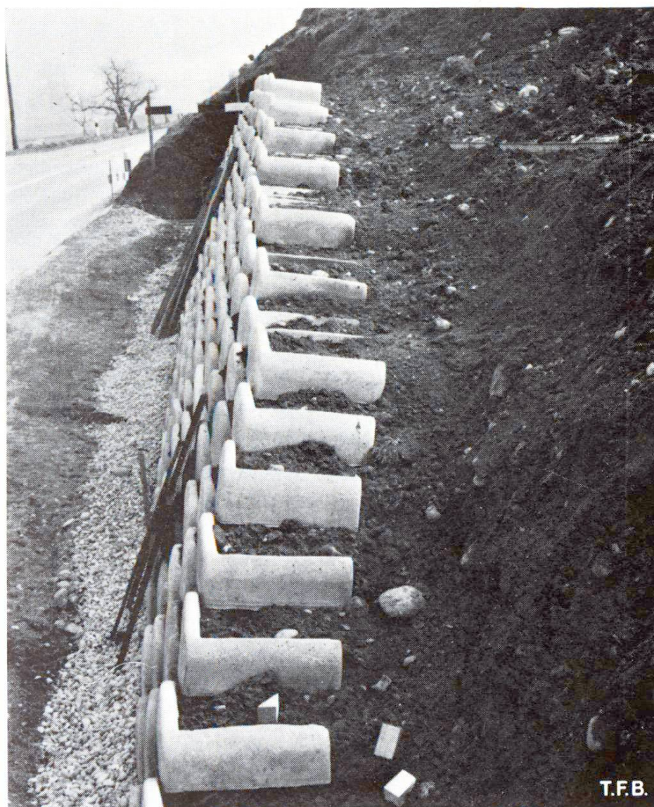
Fig. 9 Un mur en construction au moyen de «pierres en cuillère».
