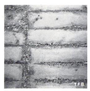
Fig. 1 Joints de coffrage non étanches
