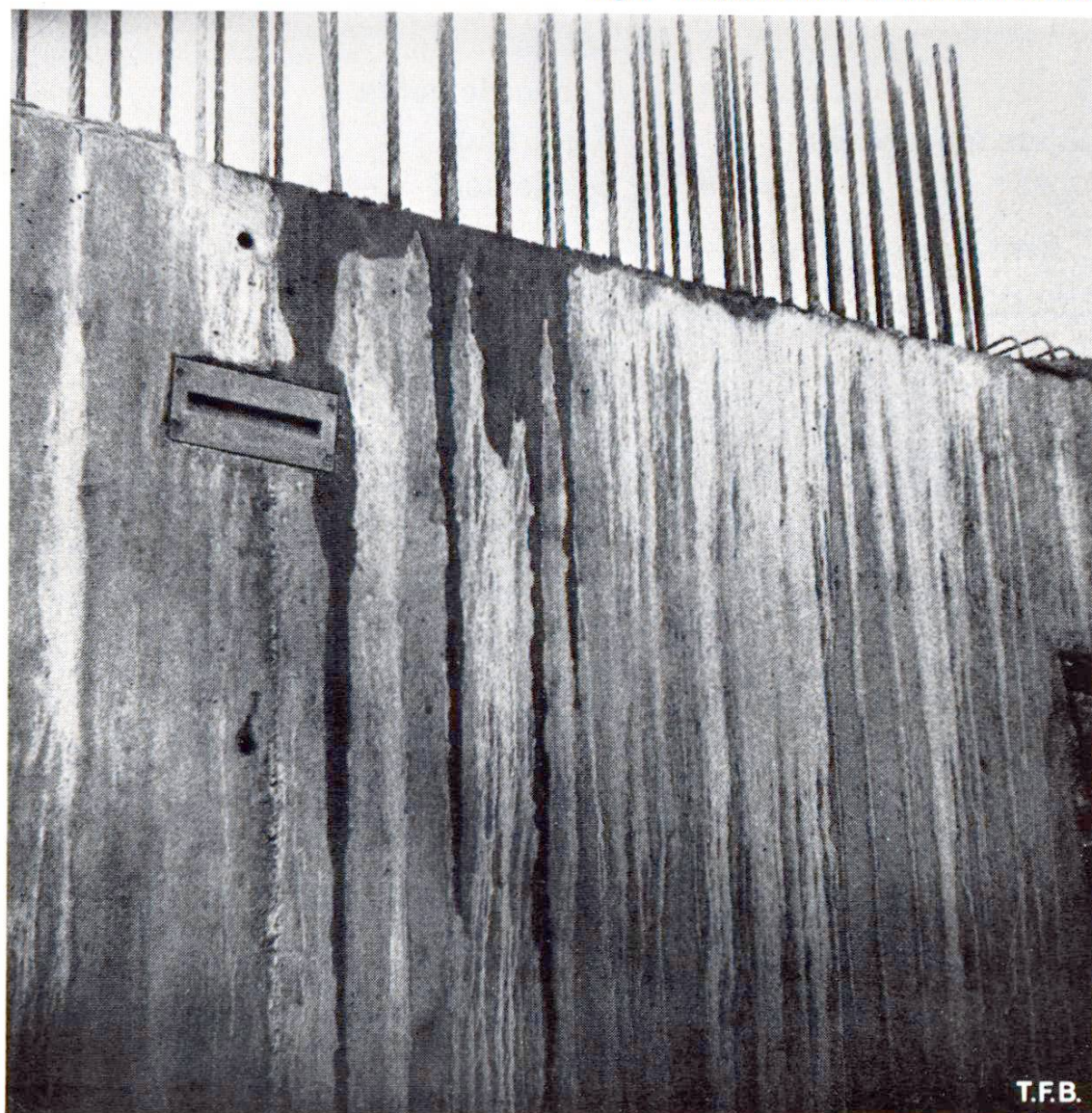
Fig. 8 Couronnement de mur non couvert
