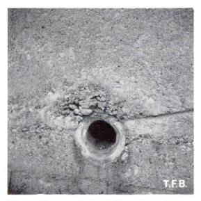
Fig. 3 Manque d'étanchéité autour d'un objet incorporé
