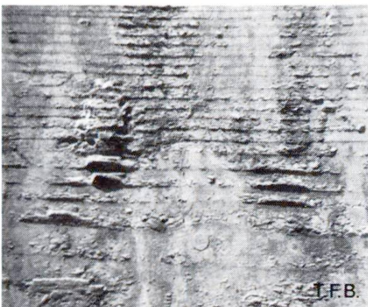
Fig. 5 Coffrage encroûté
