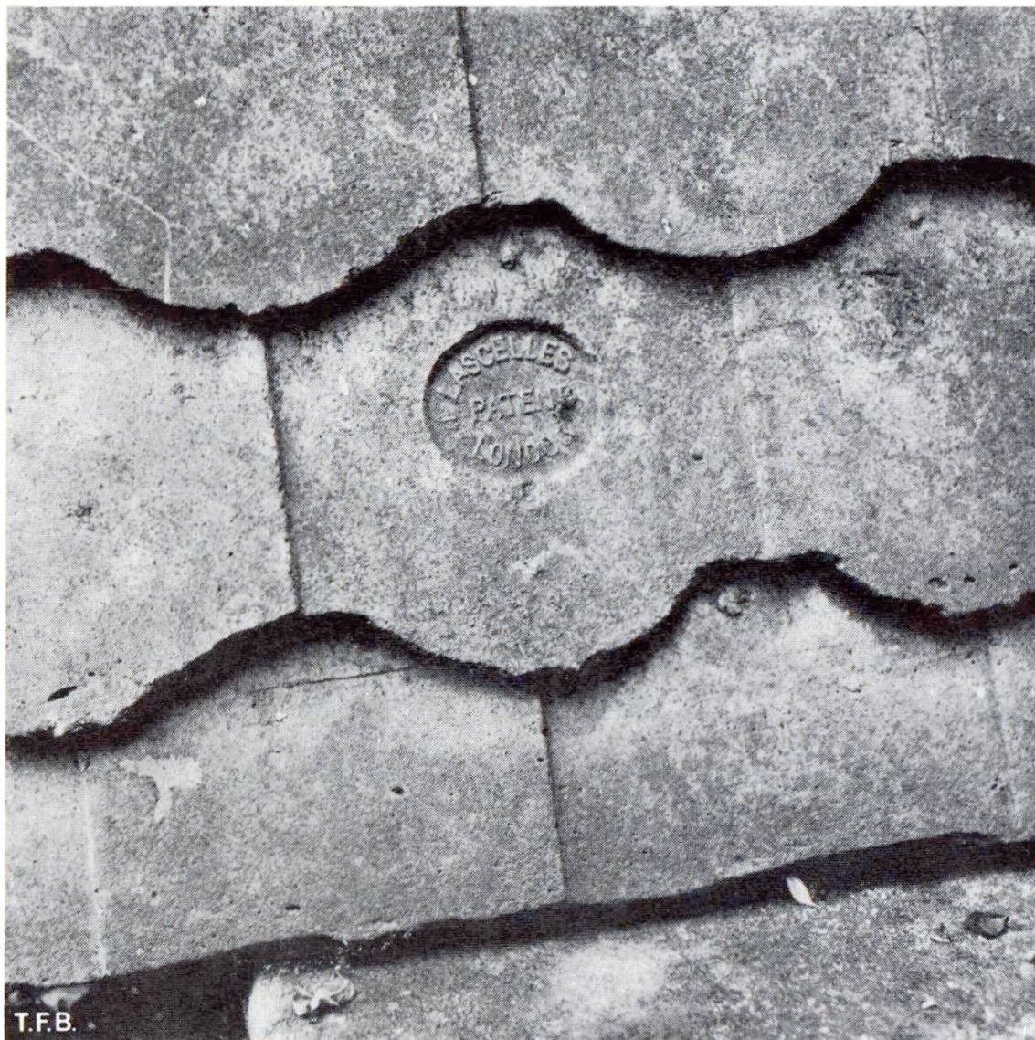
3 Plaque de béton avec motifs moulés imitant les tuiles. On distingue le sceau du brevet.
