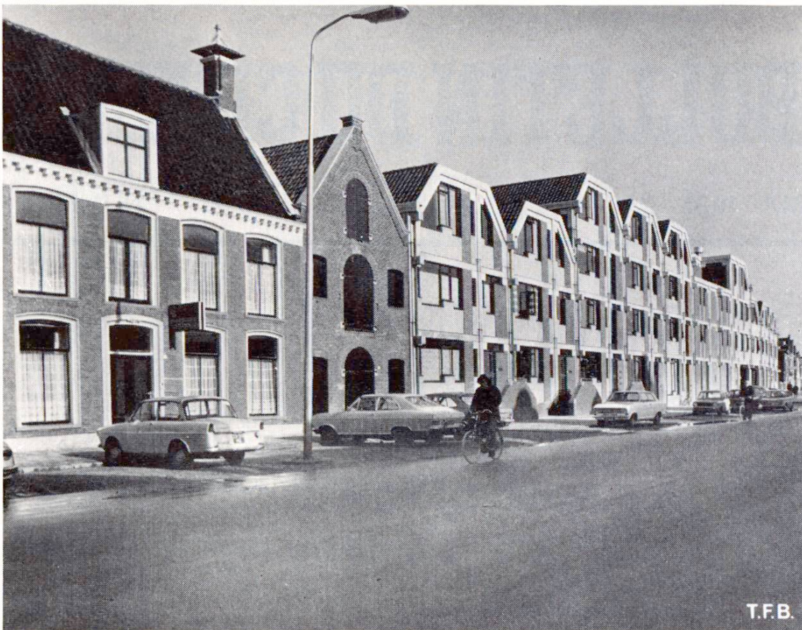
Fig. 1 La façade du nouveau bâtiment est bien adaptée à celle des vieilles maisons, le long de ce qui fut un ancien canal.
