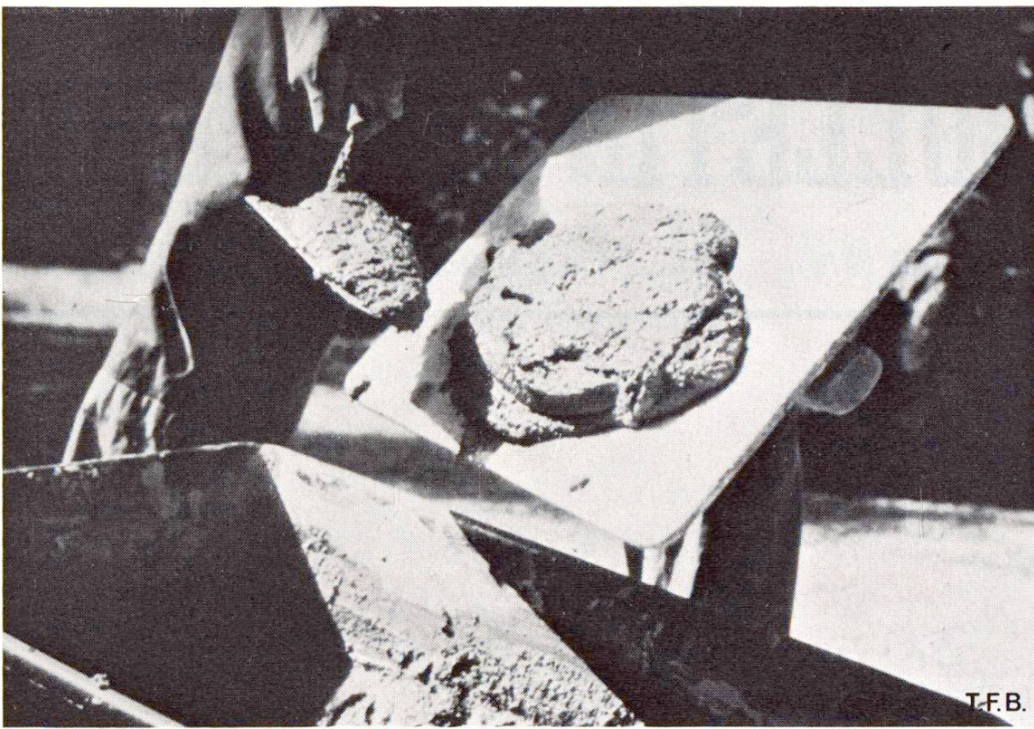
Fig. 1 Exemple d'un mortier de chaux hydraulique bien maniable.
