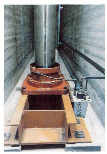
L'espace inférieur d'escamotage, avec le mécanisme hydraulique de manœuvre. On remarque le piston en position haute, la partie supérieure du cylindre, ainsi que son dispositif de fixation sur le sol. La commande d'admission d'huile sous pression se fait par un bouton électrique placé dans une des salles.
