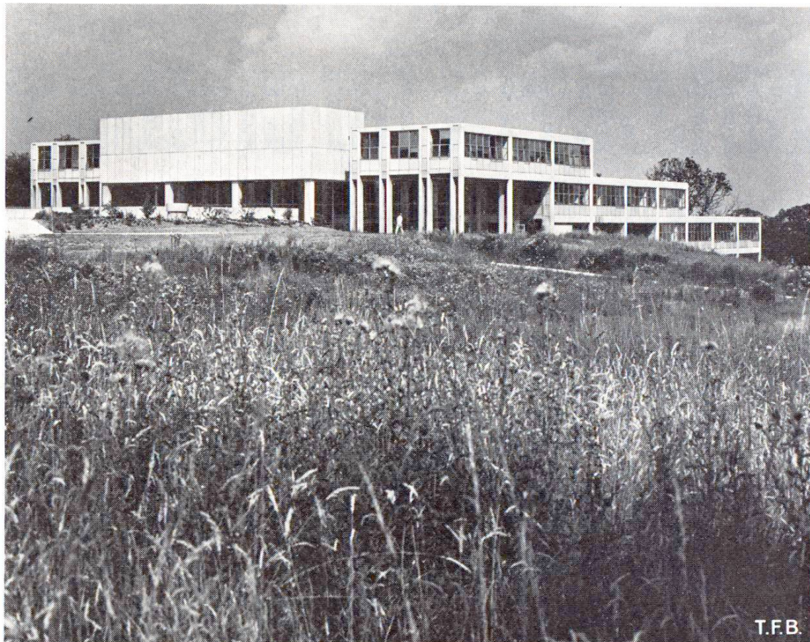
Fig. 2 Vue latérale. Le bâtiment est en escaliers pour épouser la pente du terrain descendant vers l'arrière. A la partie supérieure se trouvent la bibliothèque (dans le cube sans fenêtres), l'administration et les laboratoires. Les étages inférieurs abritent les salles de séminaires et les ateliers.
