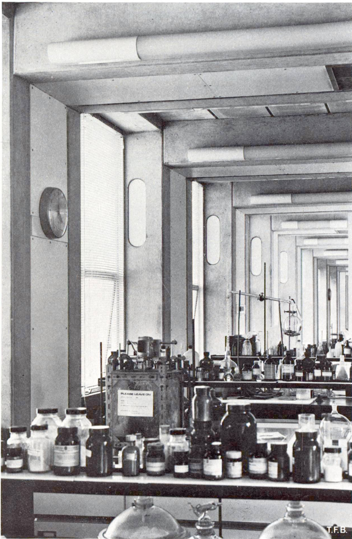
Fig. 5 Paroi vitrée d'un laboratoire. Les piliers doubles cachent les diverses canalisations recouvertes de plaques de bois contre-plaqué facilement amovibles. L'écartement entre piliers est de 3 m.
