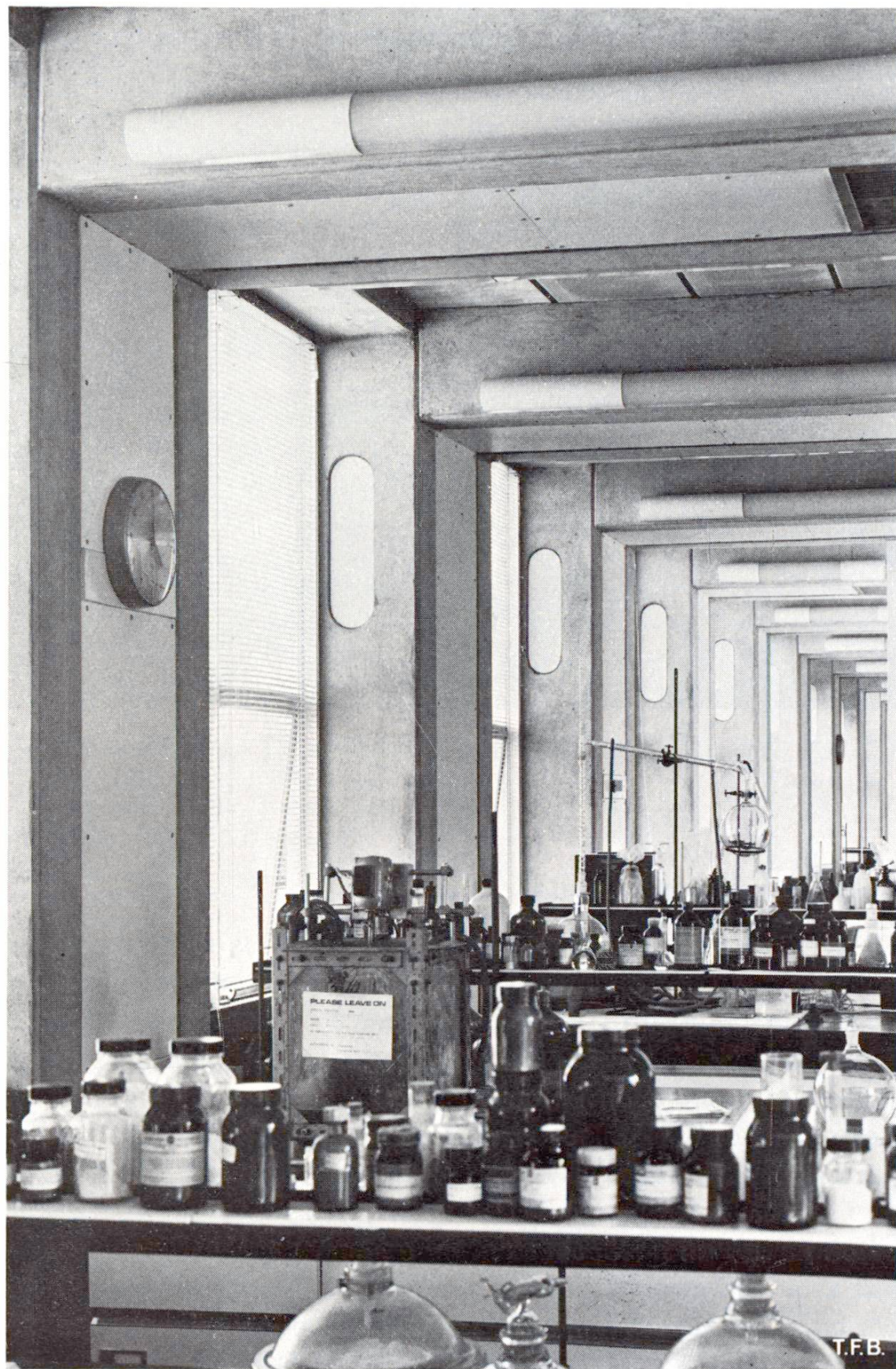
Fig. 5 Paroi vitrée d'un laboratoire. Les piliers doubles cachent les diverses canalisations recouvertes de plaques de bois contre-plaqué facilement amovibles. L'écartement entre piliers est de 3 m.
