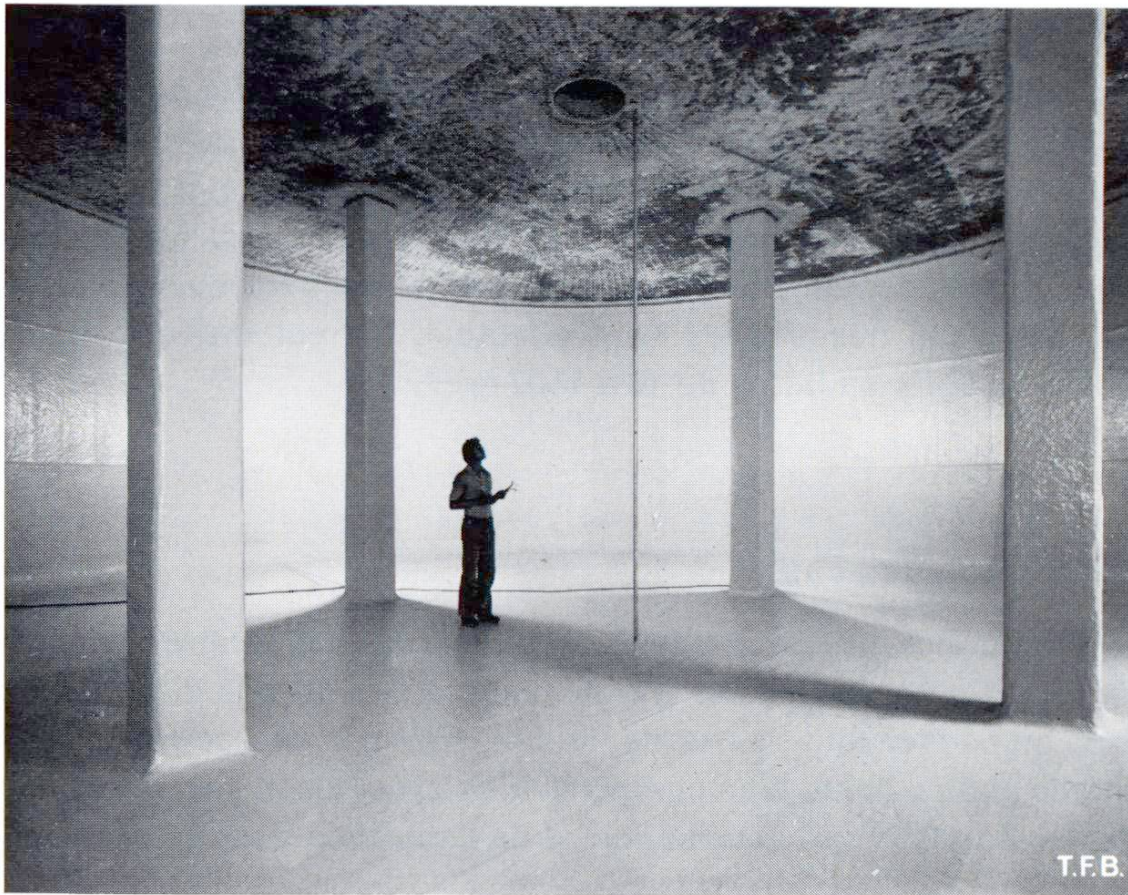
Fig. 3 Intérieur d'un gros réservoir en béton à revêtement en deux couches.
