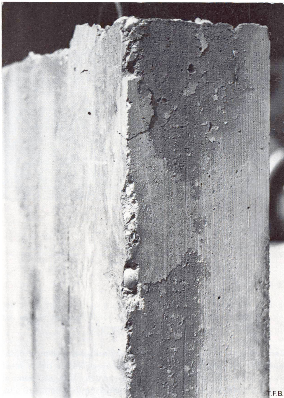
Fig. 4 Rupture d'une arête et décollements de la pellicule de ciment dans un «béton jeune», dus au gonflement d'un coffrage en bois.
