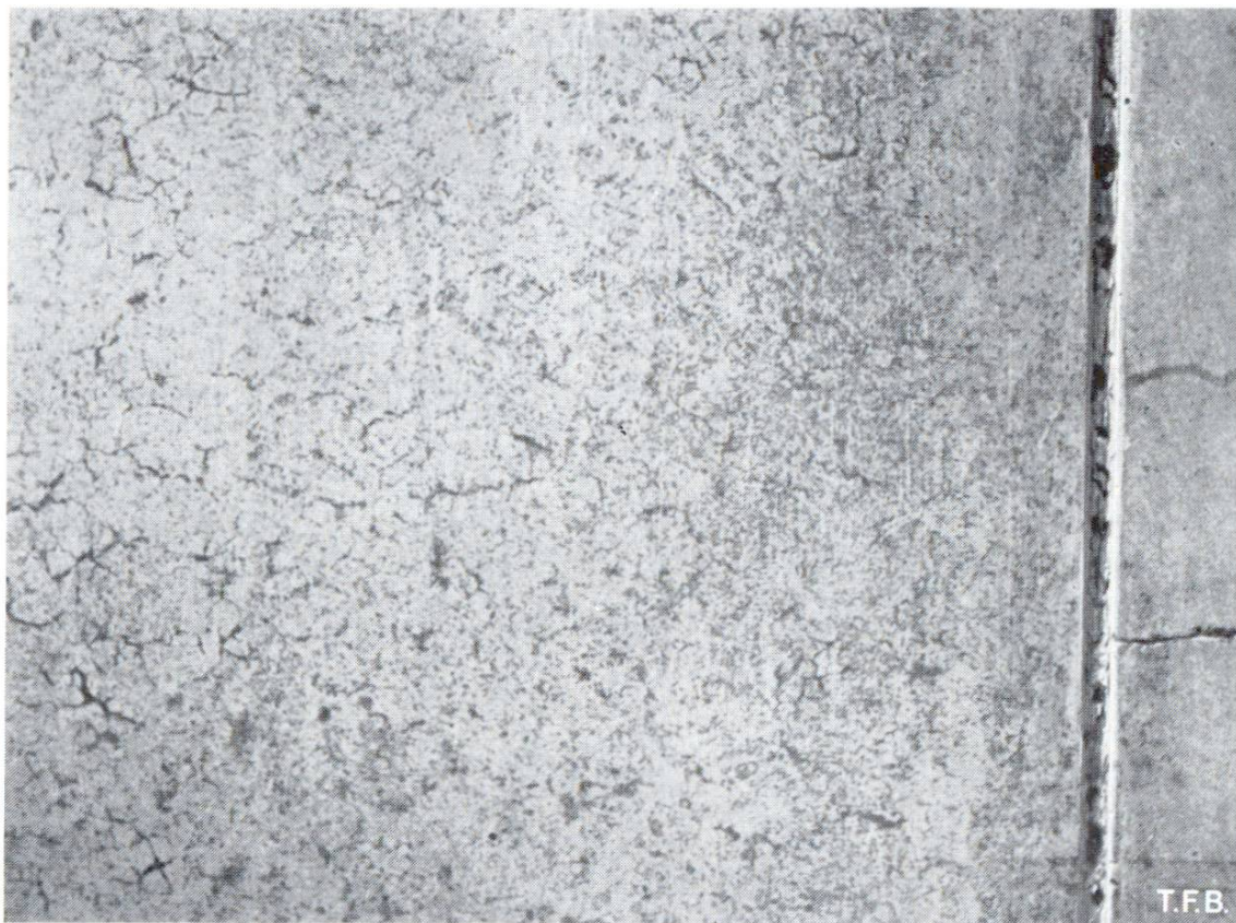
Fig. 2 Fin réseau de «fissures de retrait précoce» formé sous un coffrage lisse et imperméable. Au bord, il y a moins de fissures.
