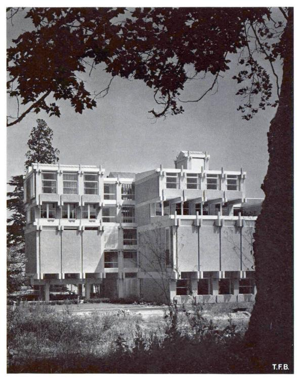
Les poutres porteuses sont ancrées dans le noyau du bâtiment constitué par une sorte de longue boîte rigide en béton coulé sur place. C'est dans ce noyau que se trouvent les escaliers, couloirs, toilettes et autres locaux de service. Le bâtiment a 120 m de long. L'espacement des poutres porteuses est de 2,40 m et la section
