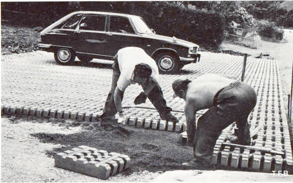
Fig. 2 Pose de pavés-grille sur une place de parc. Les éléments sont posés comme des pavés sur une couche de sable, puis les évidements remplis d'humus. Les surfaces de béton et de gazon sont à peu près dans un rapport 1:2.
