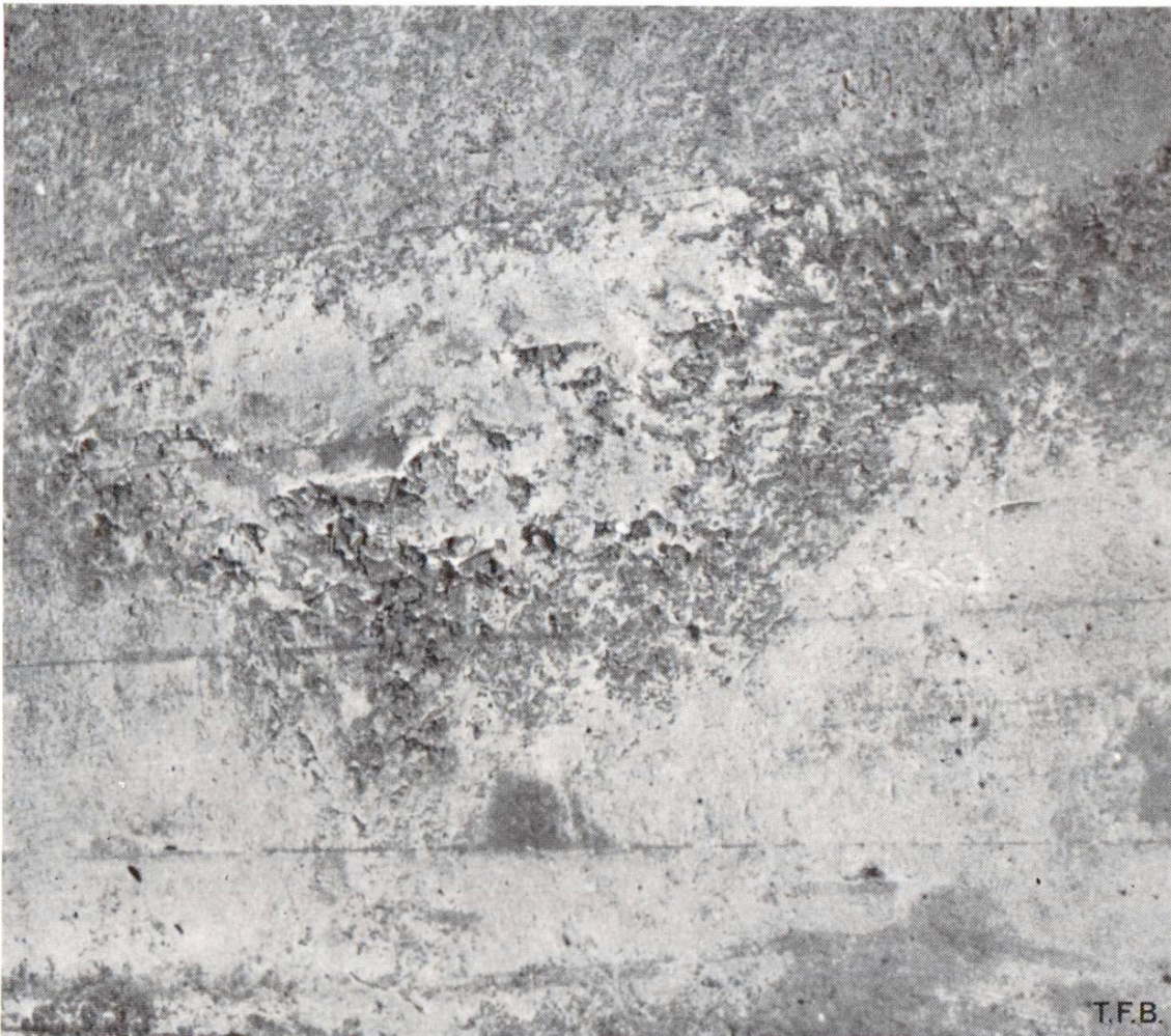
Fig. 3 Gros nid de gravier partiellement colmaté par du mortier.
