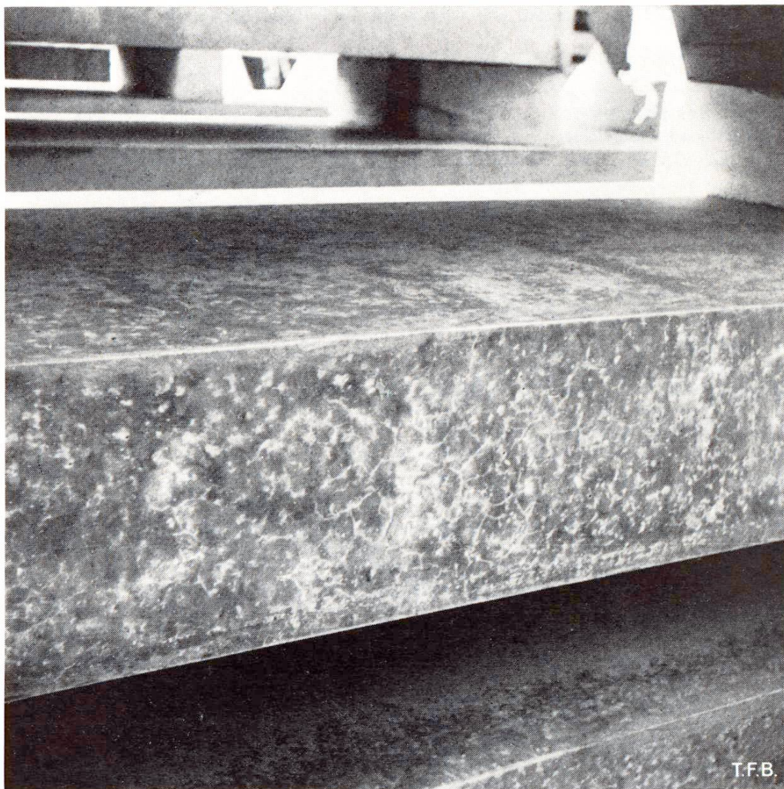
Fig. 6 Fines fissures en réseau apparaissant en blanc sur un béton à coffrage métallique. Elles sont probablement imputables à des différences de température dues à un dosage élevé en ciment. Le béton est resté foncé parce qu'il est très compact. Ce n'est qu'au voisinage des fissures que la chaux claire a été secrétée.
