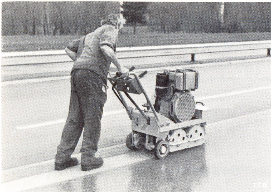
Fig. 1 Traitement de surface du revêtement en béton d'une autoroute. La machine ravive uniformément et régulièrement la rugosité de la surface par des chocs libres à effet contrôlé. Elle est pourvue en outre d'un dispositif permettant une correction automatique de la planéité de la surface, par passes successives, ainsi que d'un réglage de l'avance automatique (fournisseur: Fabrique de machines von Arx, Sissach, Suisse).
