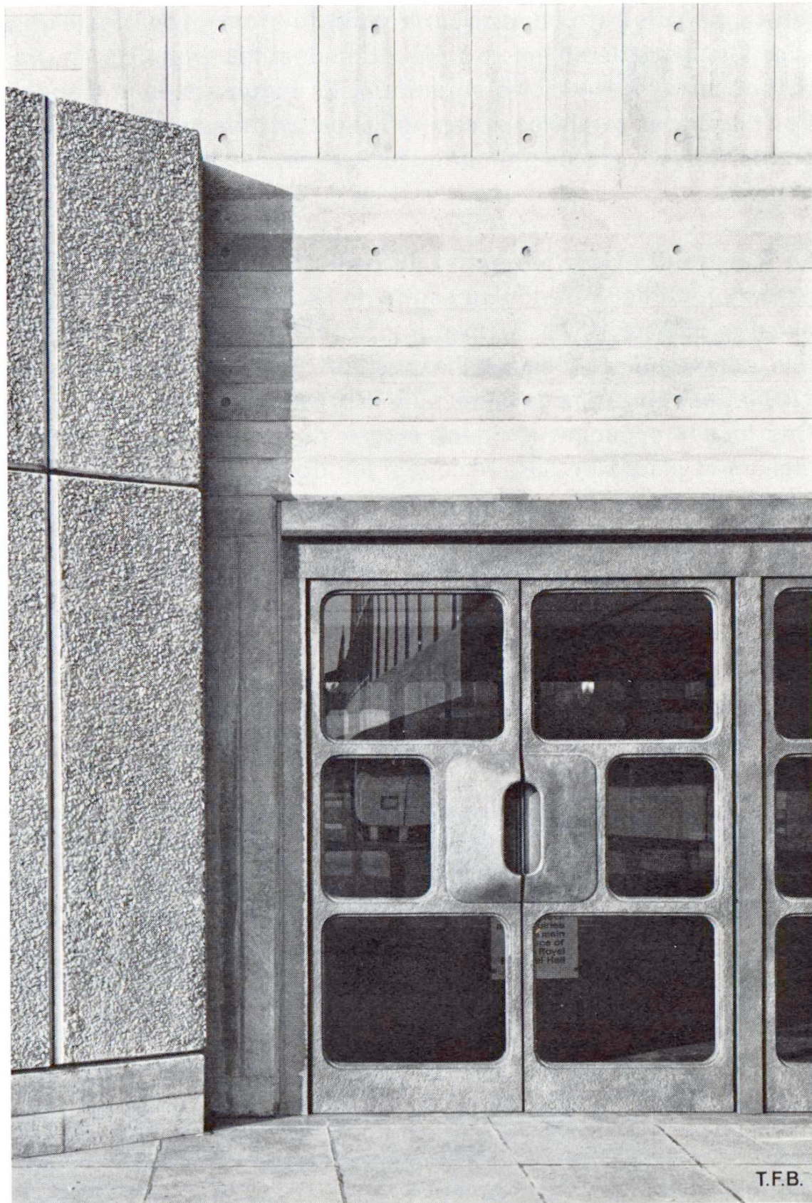
Fig. 8 Détails de la façade aux entrées: Porte en aluminium, plaques en béton à granulats saillants et béton apparent moulé sur place à dessin bien marqué et bien régulier. On remarque ici comment les trous des tiges d'écartement sont traités: ils sont parfaitement ronds et obturés au mortier compact arrêté 10 mm en retrait.
