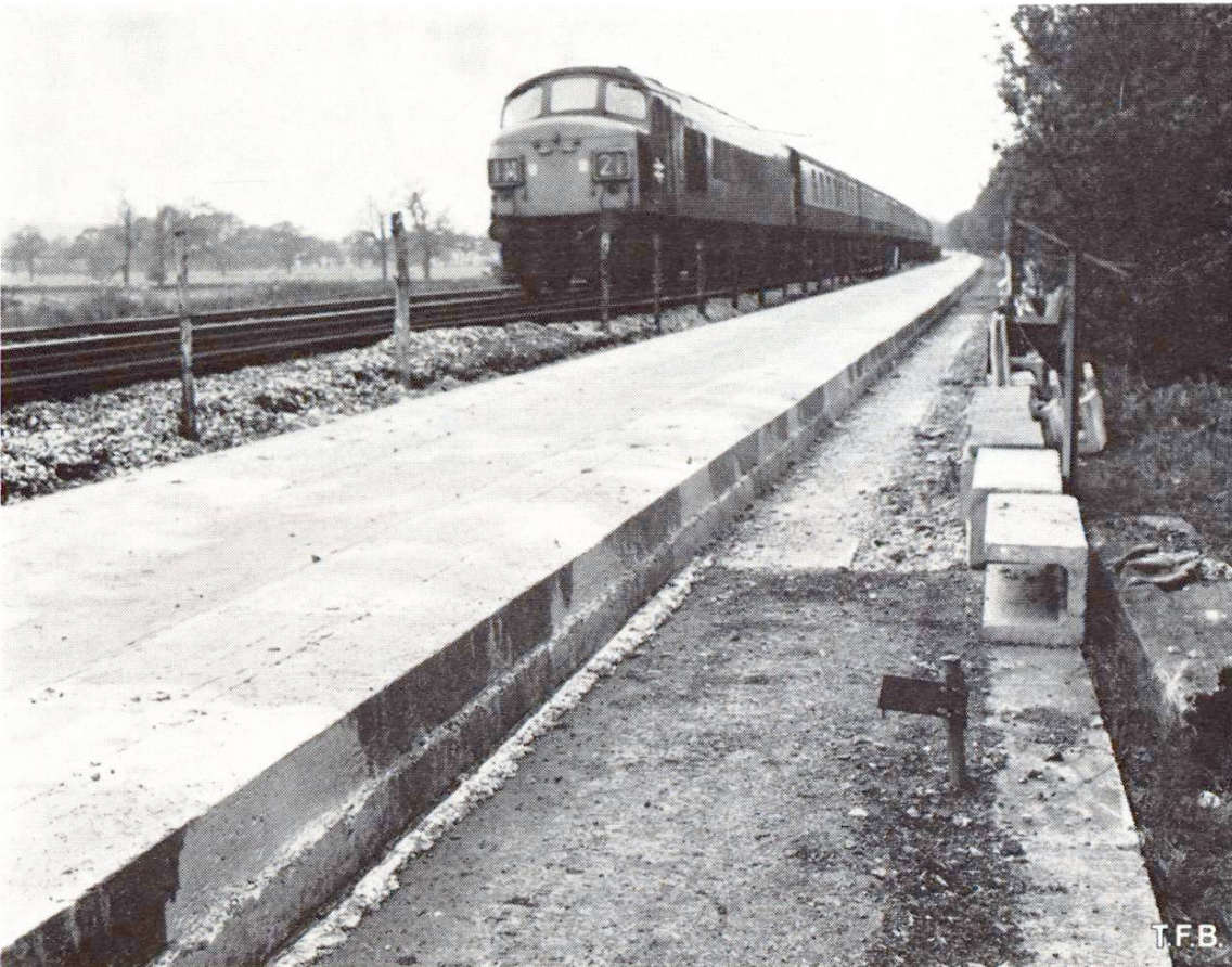
Fig. 4 Dalle de béton nue destinée à recevoir une voie. Il s'agit du tronçon d'essai pour des trains très lourds et très rapides.
