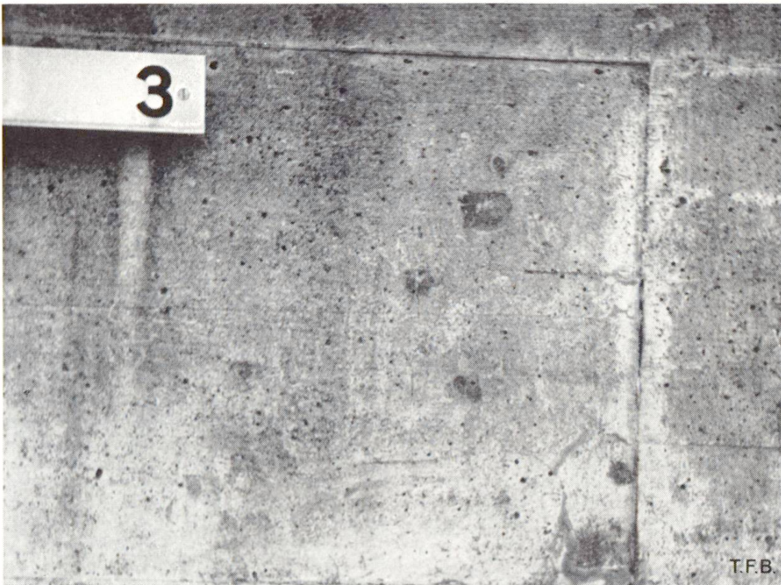
Fig. 5 et 6 Mur de soutènement ayant même fruit que celui des figures 1 et 2. Photos 1962 et 1972. Béton P 300 bien serré, coffrage en planches imprégnées. Assombrissement général de la surface dû aux lichens et à la dissolution de la pellicule superficielle de chaux. Les traces foncées du début, le long des joints de coffrage sont devenues claires. C'est la conséquence de la posthydratation et de l'absence de mousse sur ces zones particulièrement denses et riches en ciment. On remarque aussi l'augmentation du nombre des pores superficiels qui étaient à l'origine recouverts d'une mince couche de lait de ciment. Les nœuds du bois sont devenus plus visibles. Cela est dû à la croissance de mousses dans ces zones plus poreuses. Le phénomène est le même le long des joints de coffrage qui n'étaient pas étanches. La tache au coin inférieur du panneau de coffrage a de multiples causes. Nœud du bois, mauvais serrage et ségrégation ont provoqué à cet endroit une porosité plus grande du béton.
