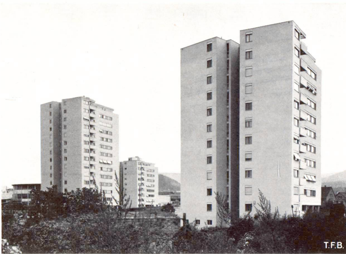
Fig. 2 Tours des CFF «Stegacker» à MuttENZ
