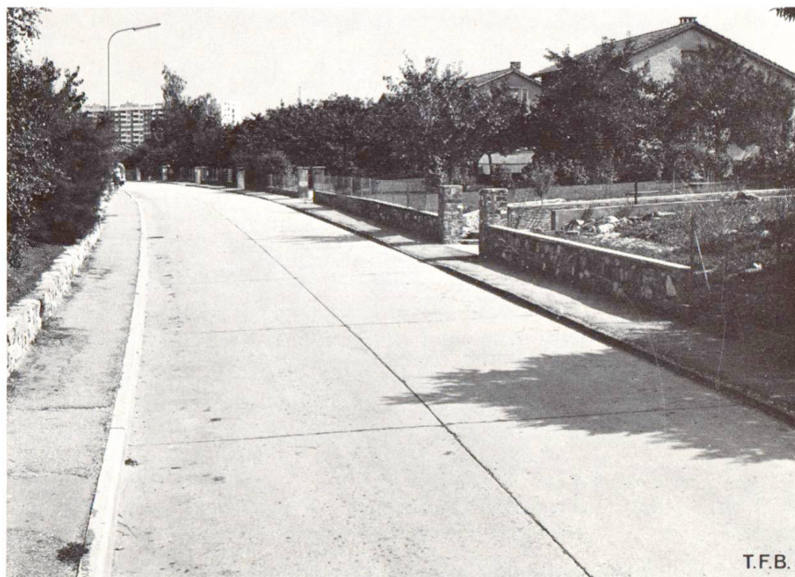
Fig. 3 Construite en 1953 pour un lotissement du « Coin de terre » au Lignon à Genève, cette route a tenu ses promesses de longévité.
