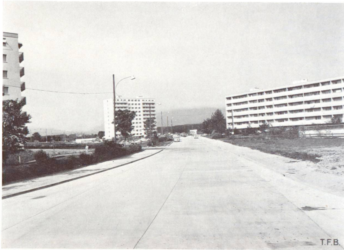
Fig. 4 L'Avenue Pierre de Savoie à Yverdon, construite en 1967 a donné accès aux grands immeubles dès leur construction hors de ville. Elle se trouve sur un terrain tourbeux compressible dont on a artificiellement suscité le tassement avant la construction du revêtement.
