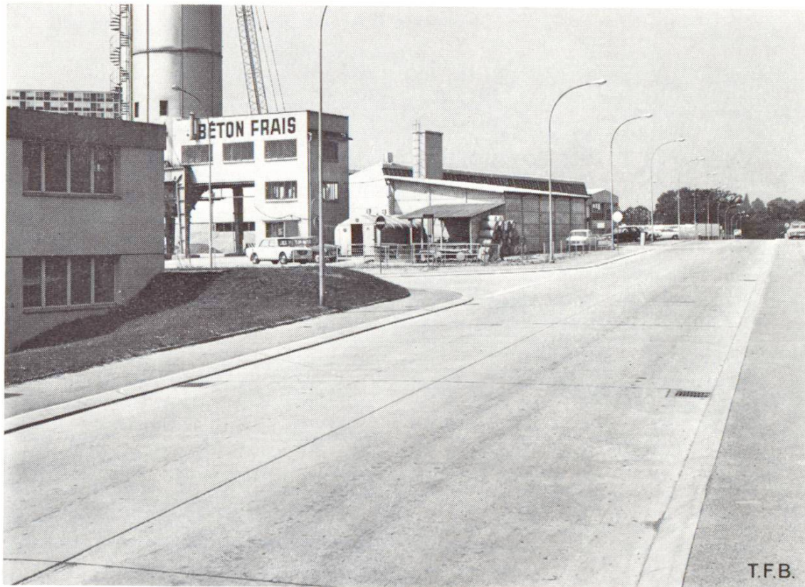
Fig. 8 Un autre aménagement industriel au Lignon, à Vernier-Genève a été équipé d'un réseau de routes en béton avant que ne viennent s'y installer diverses entreprises industrielles ou commerciales.
