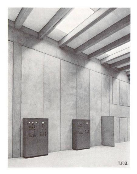
Fig. 4 Les panneaux ont la hauteur de un ou de deux étages. Une sur deux seulement des lignes verticales est un joint entre panneaux! Au milieu de chaque panneau se trouve un fer Halfen vertical pour la fixation des installations.
