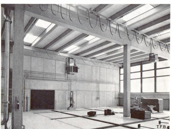
Fig. 3-5 Cloisons amovibles dans le bâtiment des laboratoires du technicum.
