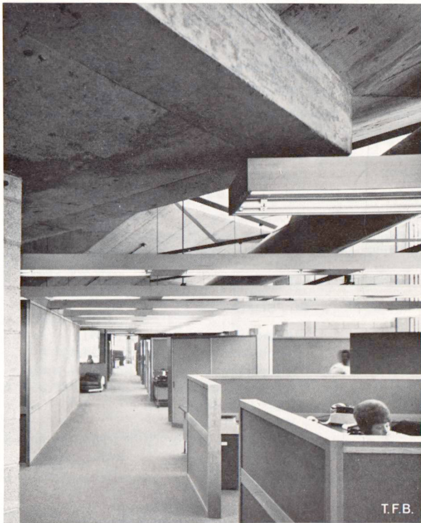
Fig. 3 Bureaux avec tapis de fond, parois mobiles en éléments de chêne et de liège, parois fixes en maçonnerie de plots de béton. Les installations sont peu nombreuses et l'on voit distinctement la toiture en béton apparent.
