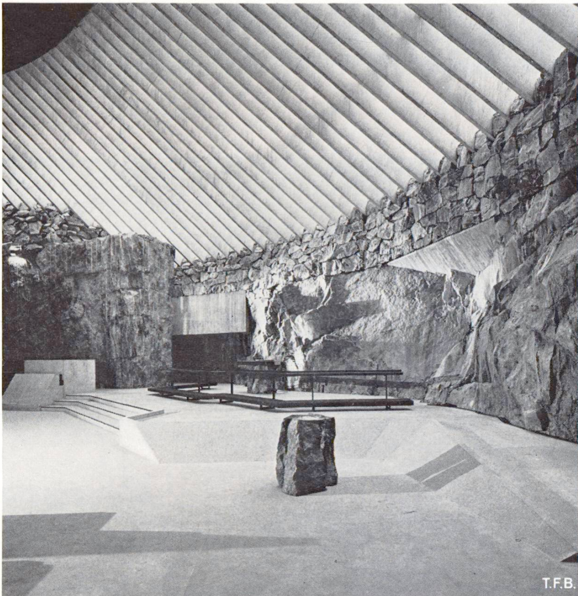
Fig. 7 De part et d'autre de l'autel, la chaire et les fonts baptismaux. Le sol est constitué de béton de différents aspects de surface.
