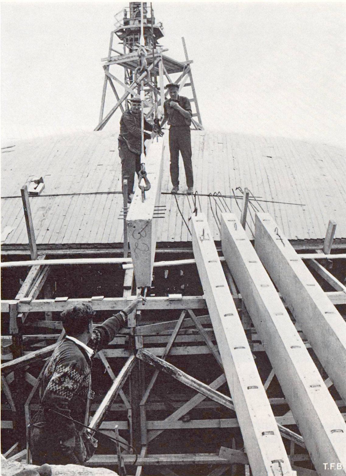
Fig. 4 Mise en place des appuis radiaux de la coupole. Il s'agit de poutres préfabriquées en béton, de différentes longueurs.
