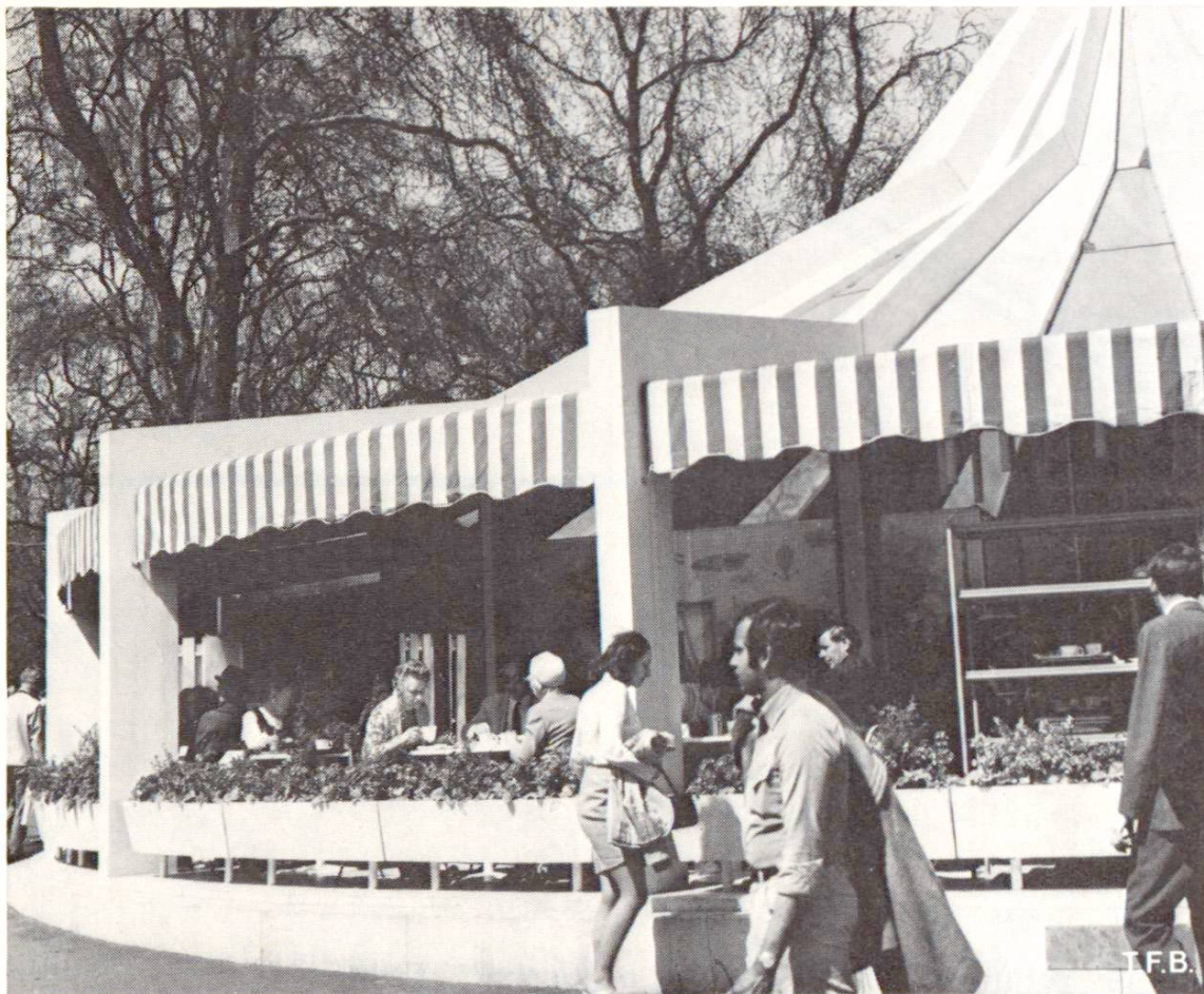
Fig. 3 Le toit circulaire est divisé en 14 segments. Les éléments en béton de ciment blanc ont une surface lissée. Entre les segments de béton se trouvent des plaques de verre.
