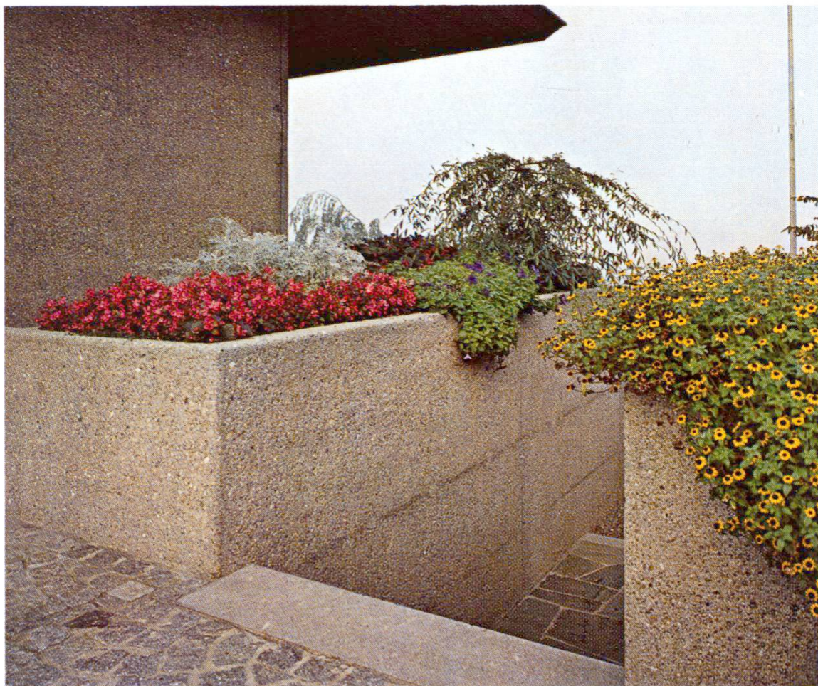
Passage entre des caissons à fleurs. Après bouchardage, de légers défauts d'étanchéité des joints de coffrage sont encore plus visibles que dans un béton apparent sorti brut de coffrage.
