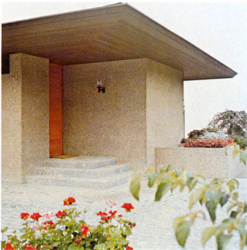
Entrée de service. Les locaux chauffés ont des parois extérieures doubles avec isolation intermédiaire.
