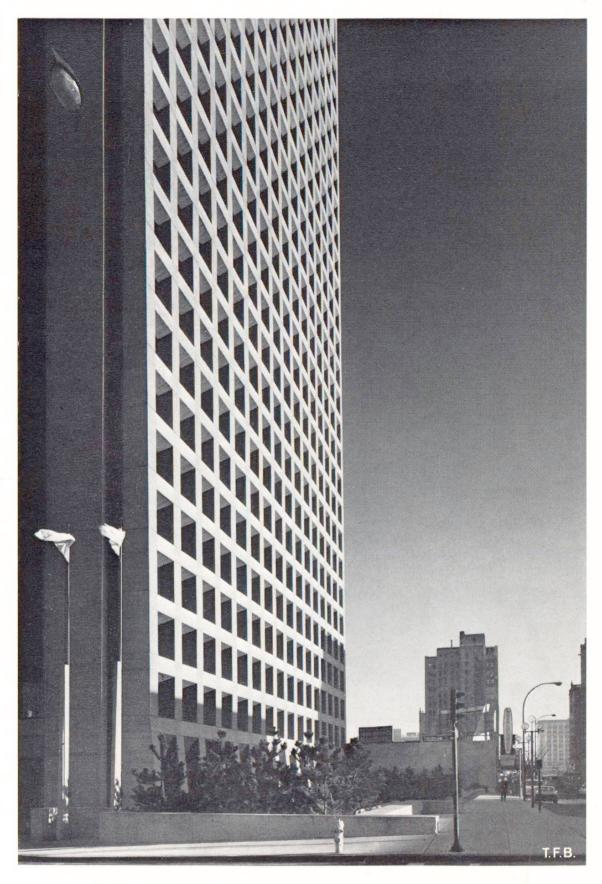
Fig. 2 Cette vue donne une bonne idée du monolithisme de la façade. Les éléments horizontaux et verticaux sont identiques avec partout une largeur de 90 cm à l'extérieur. Les fenêtres carrées de 2,15 m de côté sont plaçées en retrait et paraissent avoir été estampées.
