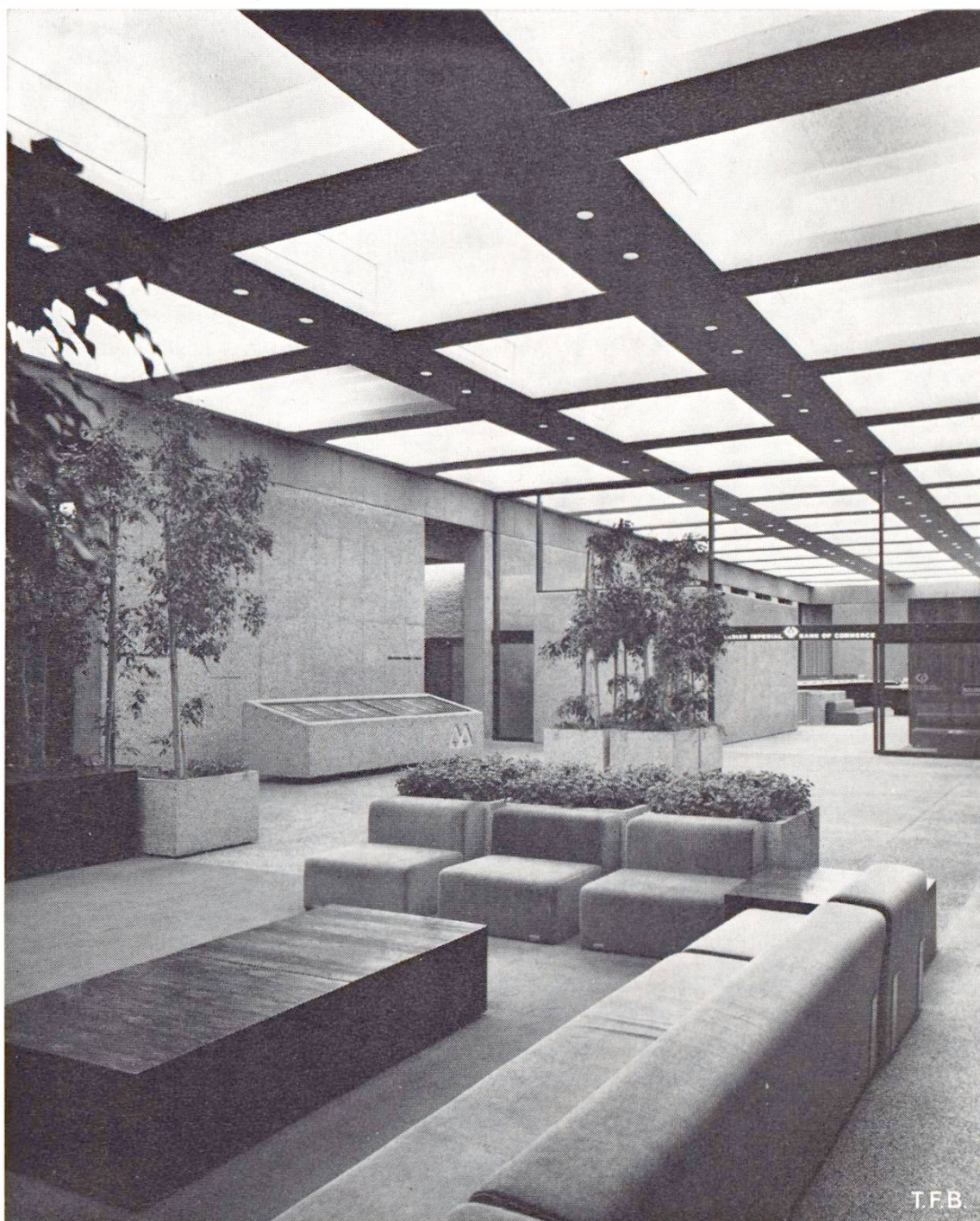
Fig. 6 Vue du hall d'entrée de 6,5 m de hauteur. Là aussi, le béton est largement apparent.
