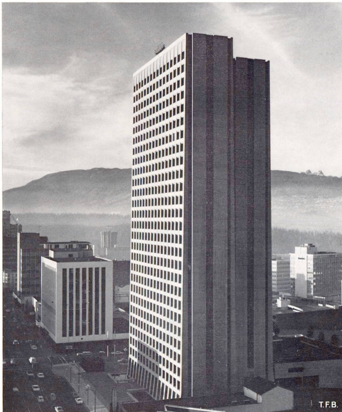
Fig. 1 Les deux tours en forme de plaques, parallèles, mais décalées. Les façades sont conçues comme parois porteuses, ce qui est mis en évidence par l'expression architecturale. Voir par exemple, au rez-de-chaussée, le fruit analogue à celui d'un mur de soutènement, et vers le haut, la diminution d'épaisseur des parois. Les façades secondaires sont formées par deux caissons verticaux autoporteurs, dans lesquels sont placées les différentes canalisations, notamment pour la climatisation.
