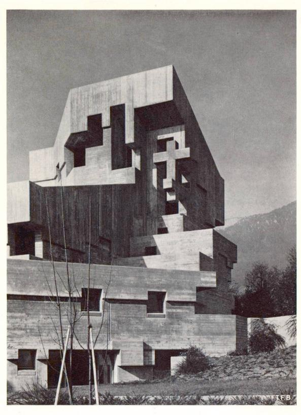
Fig. 5 Eglise St-Clément, Bettlach SO Béton apparent de Leca, ciment 325 kg/m³, parois extérieures 45 cm (Architecte: W. M. Förderer, Bâle. Ingénieur: Emch et Berger, Berne)
