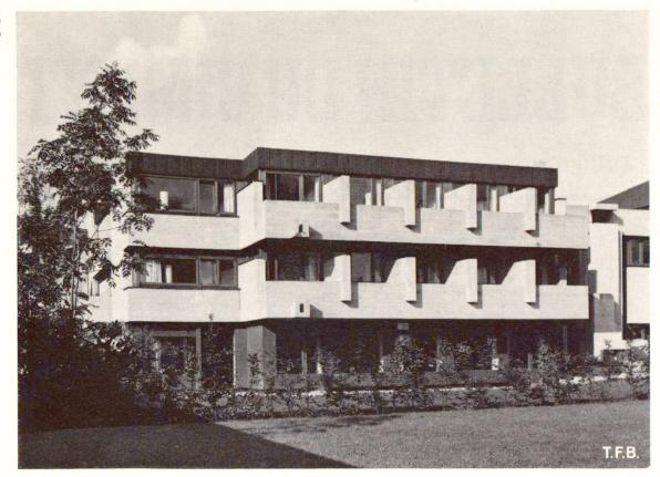
Fig. 1 Paulus-Akademie, Zurich-Witikon Béton apparent de granulats Leca, ciment 320 kg/m³, parois extérieures 35 cm (Architecte: Dr J. Dahinden, Zurich – Ingénieur: Desserich et Funk, Lucerne)
