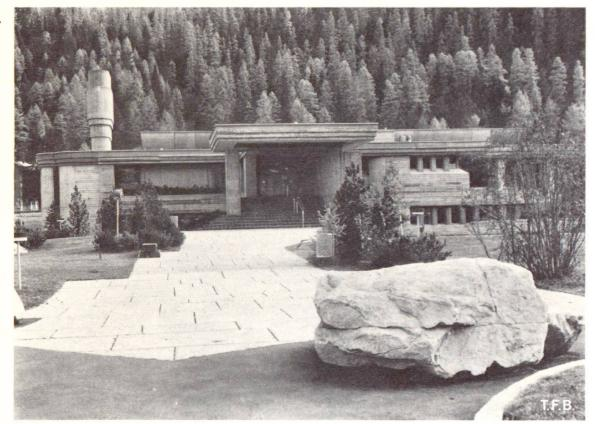
Fig. 4 Piscine à St-Moritz Béton apparent de Leca, ciment 350 kg/m³, parois extérieures 60 cm (Architecte: R. Obrist et A. Theus, St-Moritz. Ingénieur: Jenatsch et Hegland, Coire)
