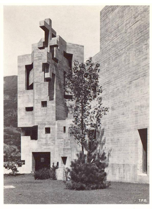
Fig. 3 Eglise catholique de Coire Béton apparent de granulats Leca, ciment 320 kg/m³, parois extérieures 45 cm (Architecte: W. M. Förderer, Bâle. Ingénieur: Schwander et Flisch AG, Coire)
