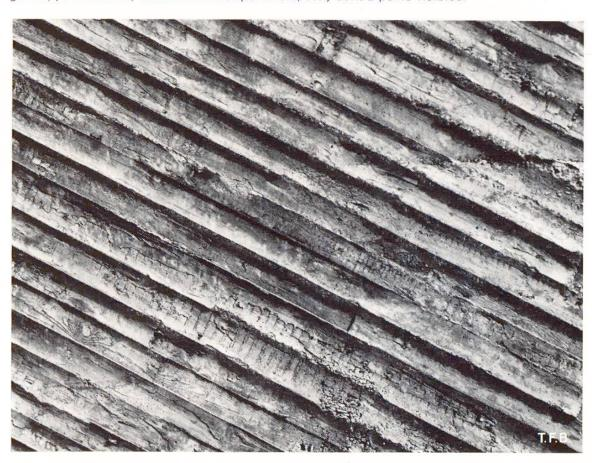
4 Le problème consistant à donner au béton une surface plus agréable et plus chaude se pose tout spécialement dans la préfabrication. De plus en plus, on réalise les dalles de façades en béton lavé. C'est un procédé réalisable en atelier, mais relativement coûteux. Ce qu'il faudrait imaginer, c'est le moyen de réaliser facilement des empreintes ornementales sortant directement de coffrage. On n'a pas encore trouvé une solution vraiment satisfaisante à ce problème.
