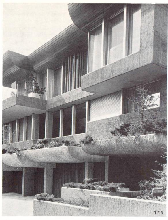
Fig. 5 Structuration de la surface d'un béton apparent au moyen de branches de noisetier clouées à l'intérieur du coffrage. Villa familiale à Kilchberg ZH. Architecte: R. Mathys, Zurich.
