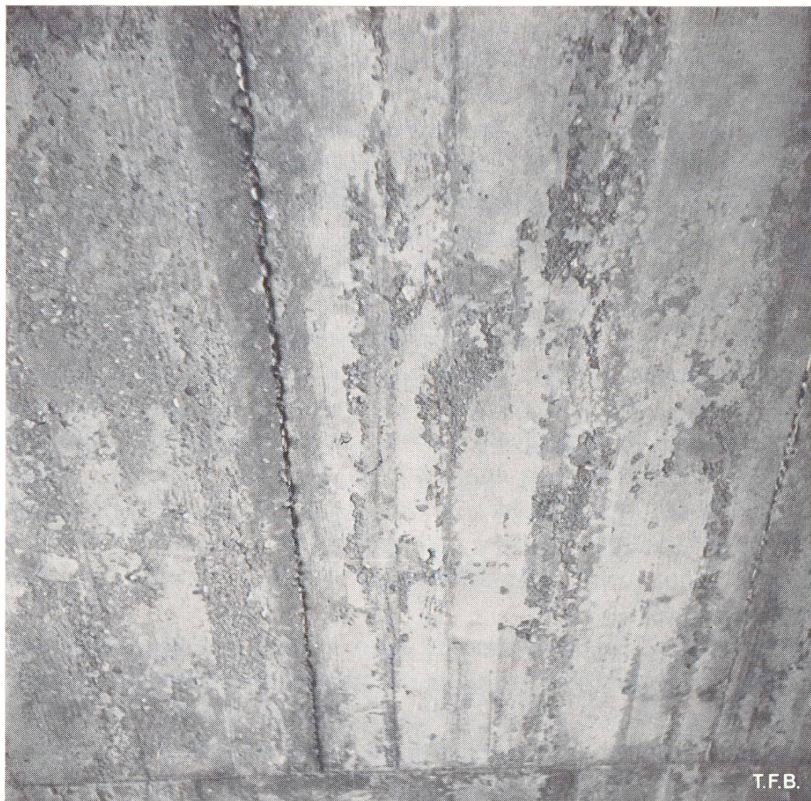
Fig. 7 Importants décollements de la pellicule de ciment à la face inférieure d'une dalle; ils sont dus à un affaiblissement du mortier par excès d'eau (segrégation de l'eau à la surface du coffrage).
