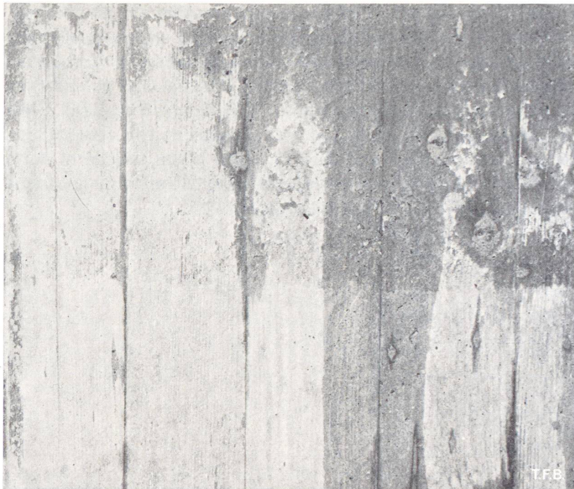
Fig. 4 Décollements de la pellicule de ciment dus à des voilements des planches de coffrage (3 e et 4 e planche à partir de la gauche; (représentation schématique à la fig. 2, au milieu). À la partie supérieure on remarque d'autres décollements dus à de légers glissements du béton le long du coffrage.
