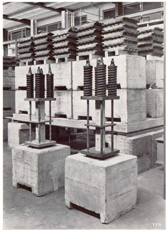
Fig. 2 Dalle III et prismes sous compression axiale.
