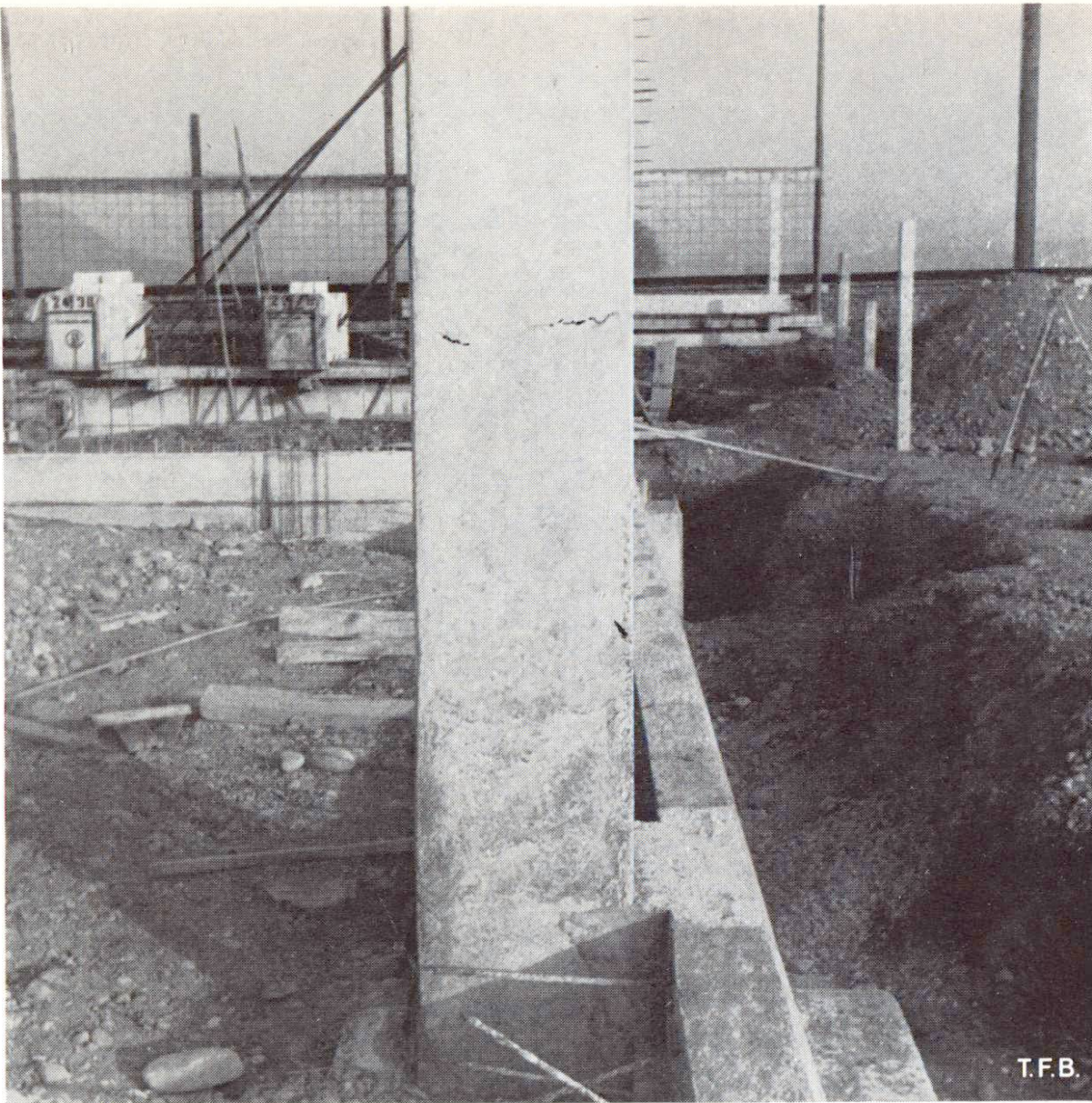
Fig. 6 Gonflement du coffrage de la base d'un pilier avec pour conséquence des fissures de tassement.
