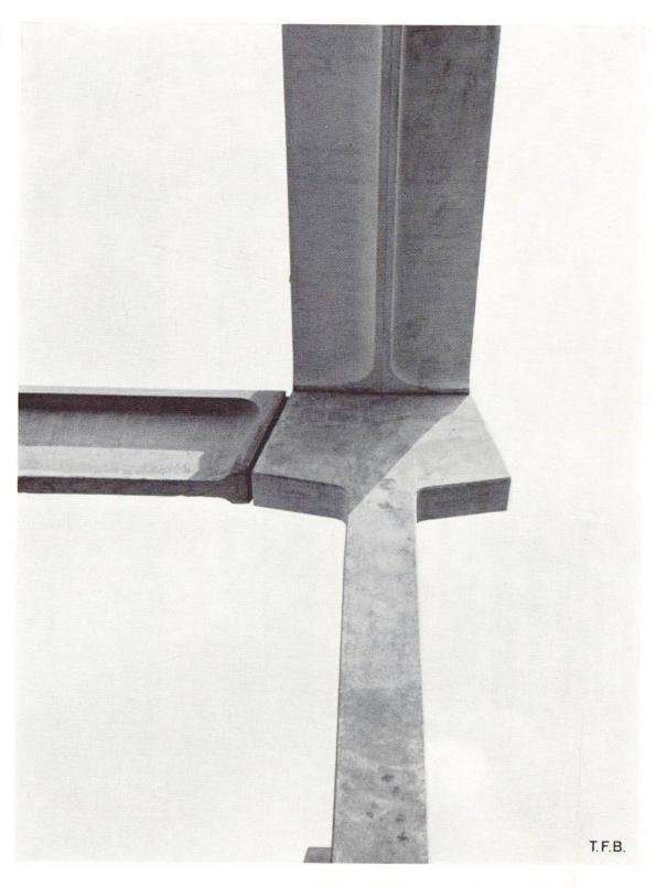
Fig. 2 Les trois éléments correspondent aux trois axes de coordonnées rectangulaires en un point.
