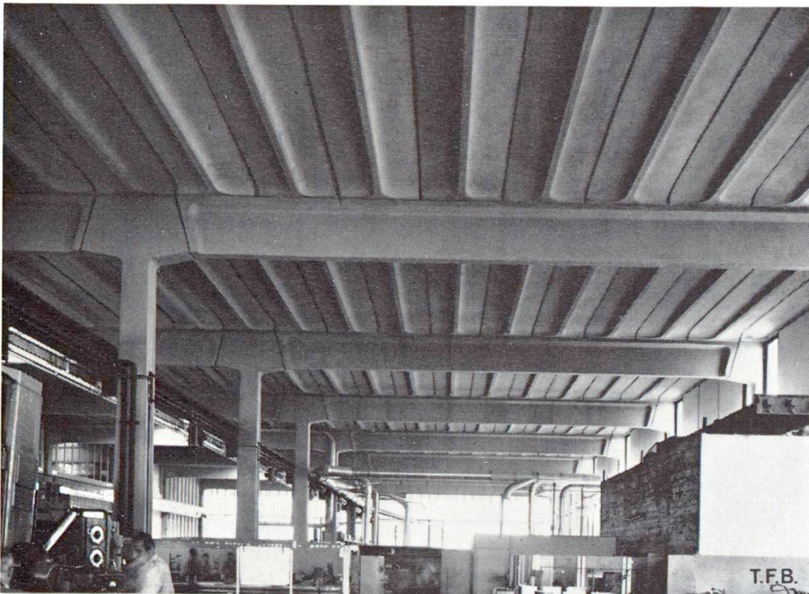
Fig. 4 Vue à l'intérieur de la halle de fabrication.
