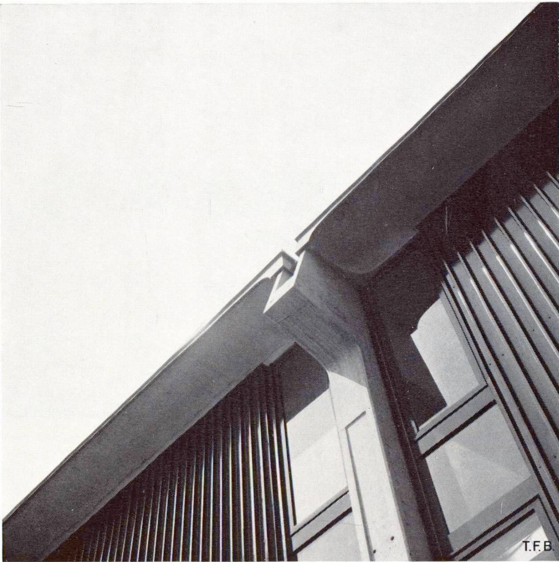
Fig. 5 Détails de la façade. Revêtement en aluminium et en verre.
