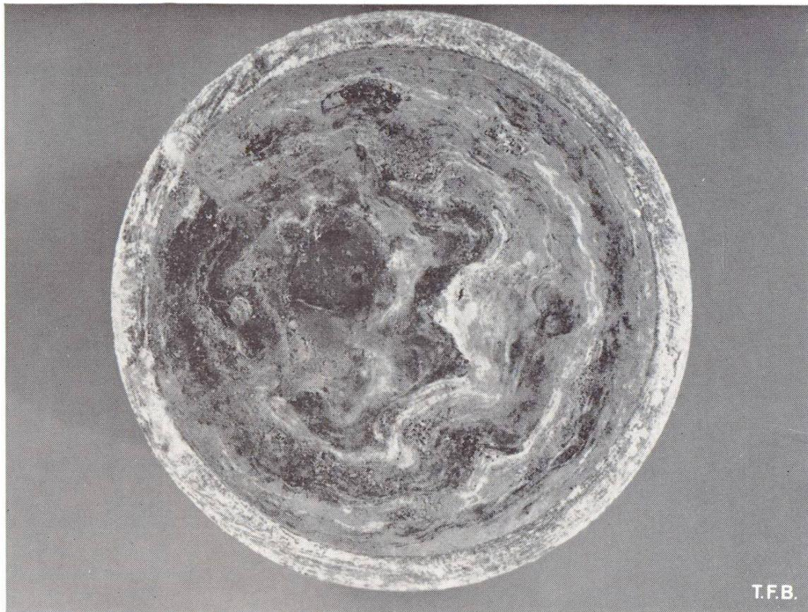
Fig. 1 Concrétions de chaux dans le tuyau de descente d'un grand toit plat. Les dépôts ont provoqué une obturation totale de la conduite.
